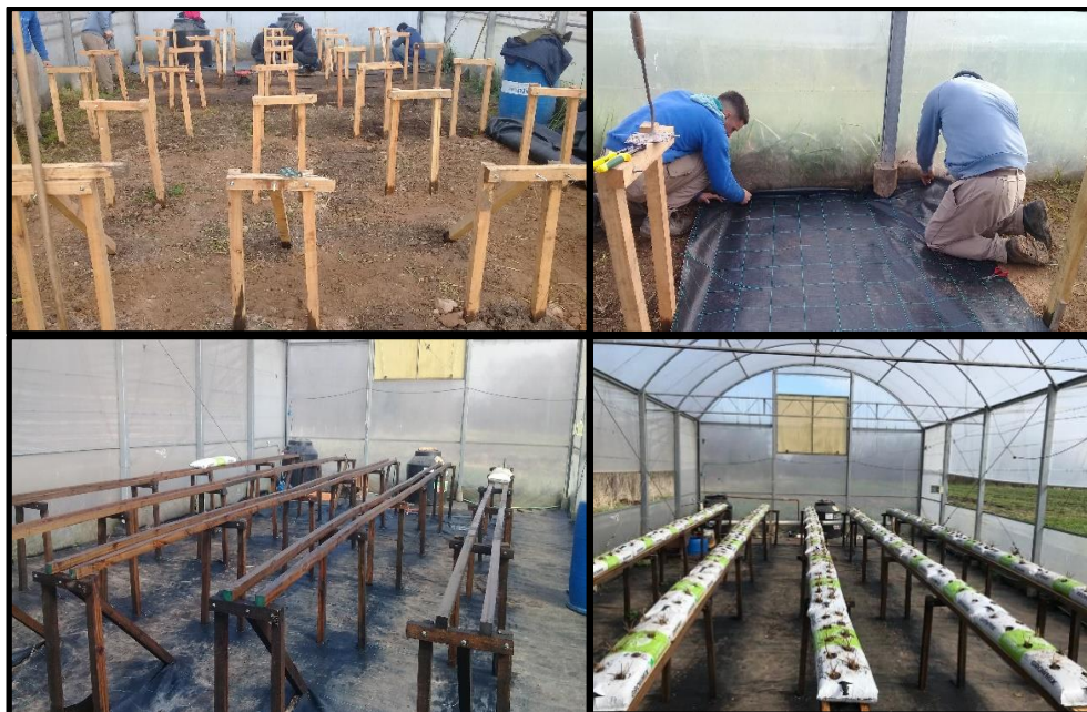
Figura 53. Construcción de la estructura de sostén de los sacos de cultivo y colocación de la malla “cubre suelo”
