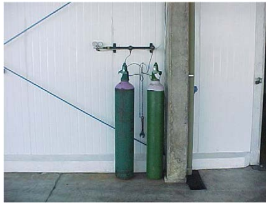
Figura 19: Arriba: Cámara de desverdizado. Abajo tubos de etileno y dosificador.
