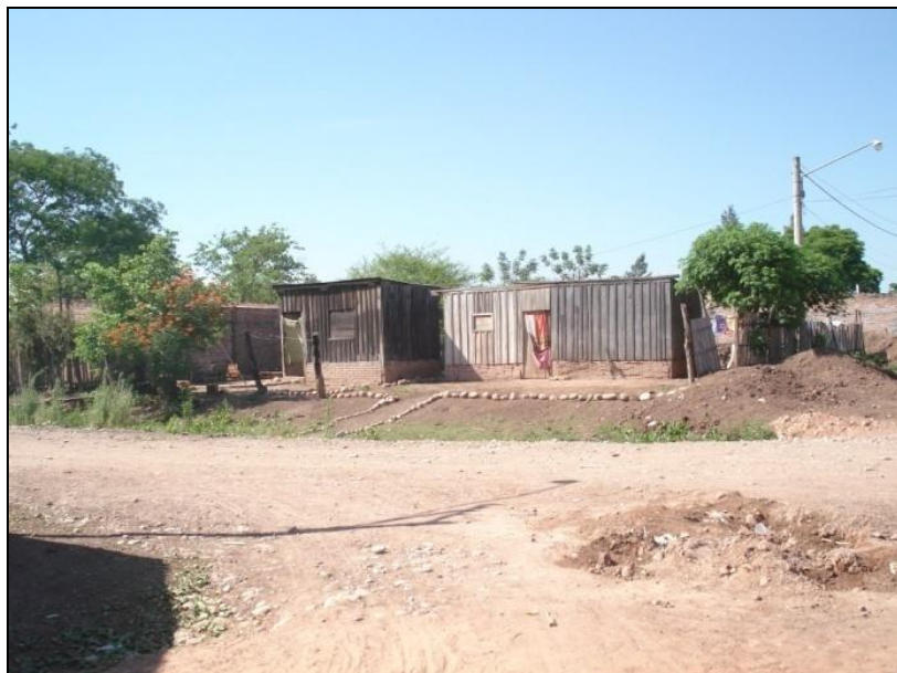
Foto N° V: Vivienda del Barrio 17 has
