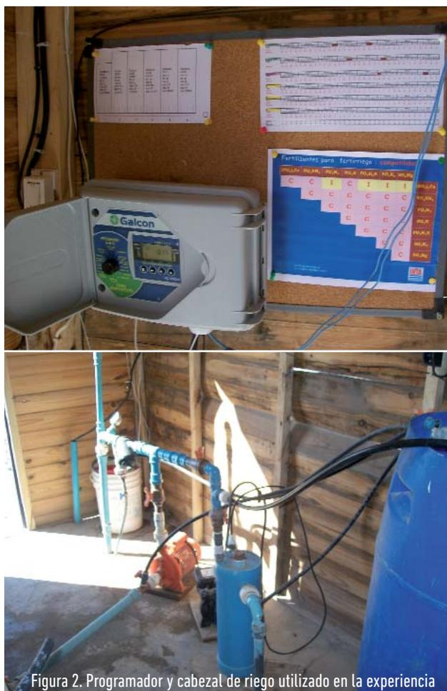
Figura 2. Programador y cabezal de riego utilizado en la experiencia
