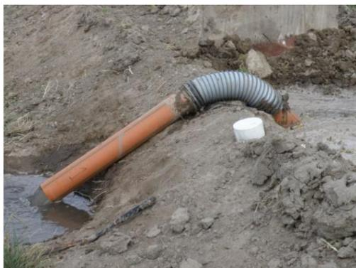
Figura 2.7: Sifón de PVC de 110 mm de diámetro.
