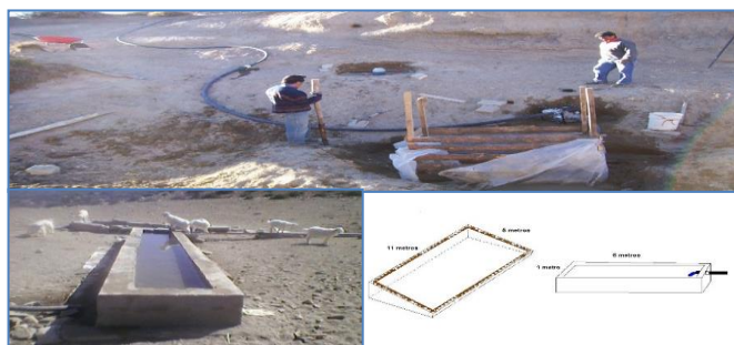
Figura 3: Captación vertiente concentrada en cañadón y bombeo. Bebederos y diseño de pequeña represa.
