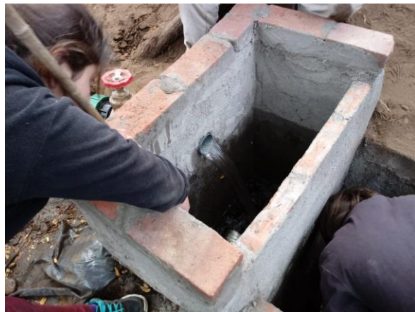
Figura 3: Cámara de carga.
