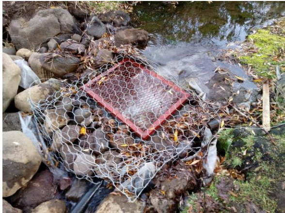
Figura 2: Toma de fondo con rejilla.
