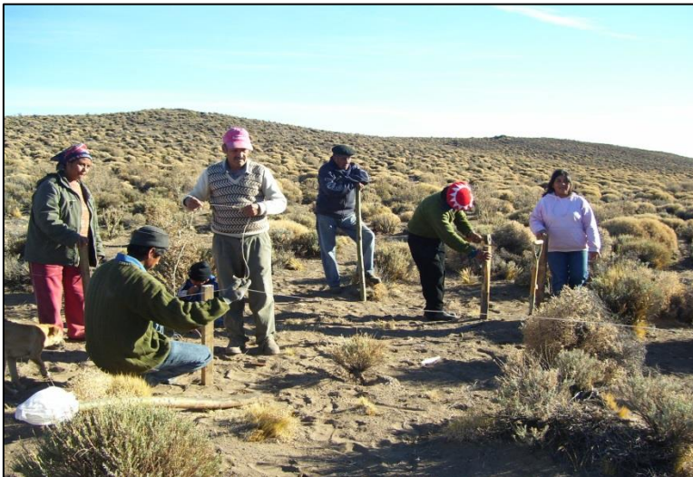
Replanteo de futuro predio comunitario
