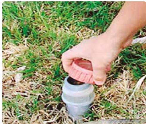
FOTO 07.a Terminación con tapa roscada.
