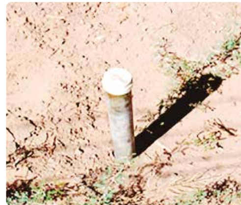
FOTO 07.b Terminación con tapón de 50 mm.
