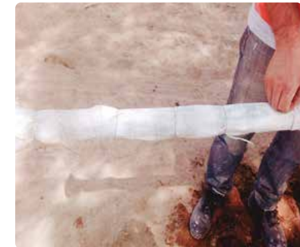
FOTO 06.d Protección con tela permeable.
