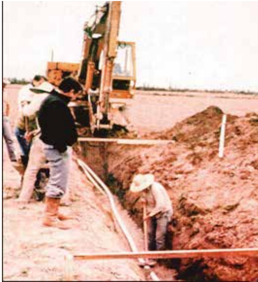
Foto11 Construcción de un dren entubado.
