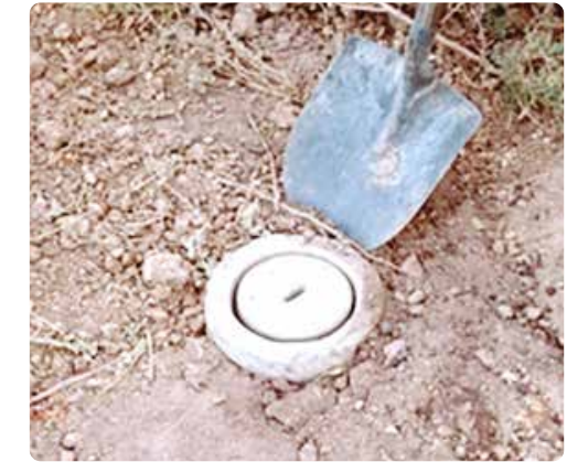
FOTO 07.d Freatímetro terminado.
