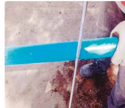
FOTO 06.c Ranurado del tubo.
