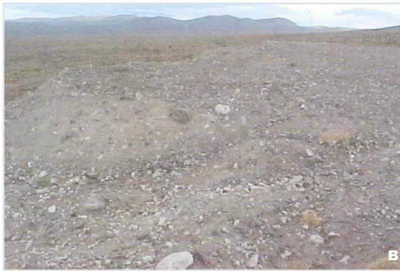
Fig. 6. A-B. Relleno y explanada.
