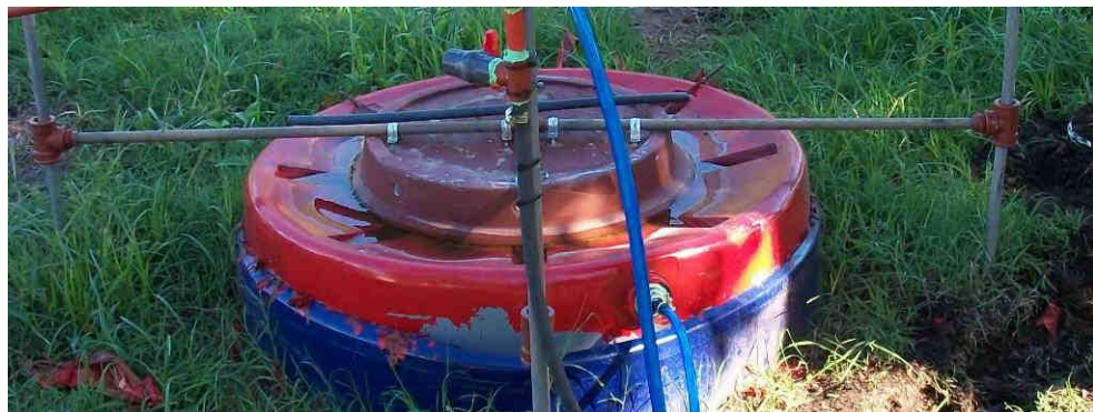
Figura 33 – Vista de guías colocadas en el gasómetro.
