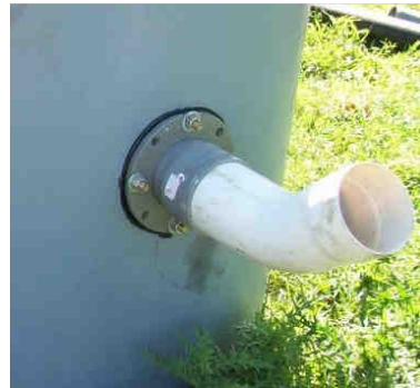
Figura 6 – Colocación de la brida y curva
