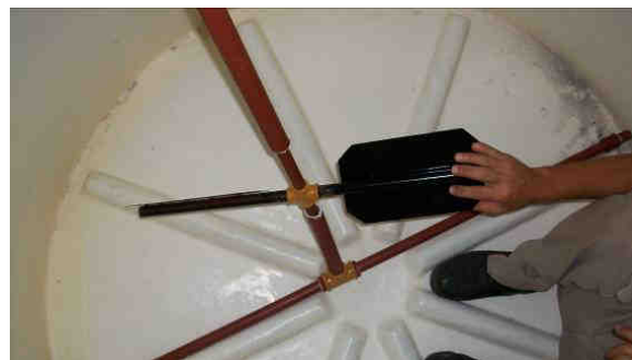
Figura 13 – Montaje de agitador dentro del biodigestor.
