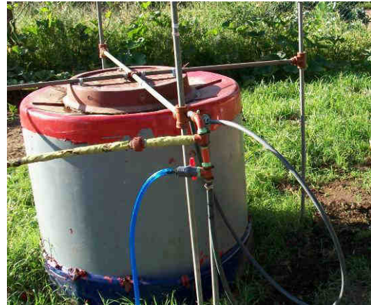
Figura 35 – Colocación de manguera negra para lograr el ascenso y descenso del gasómetro
