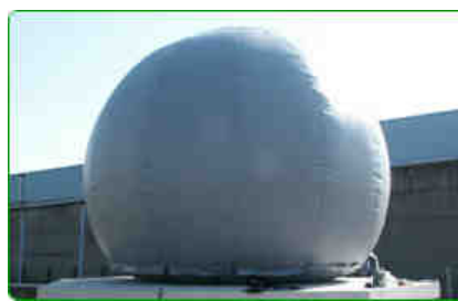
Figura 2 Gasómetro de membrana Imagen obtenida de http://www.bsdv.com
