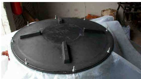
Figura 16 – Colocación y amurado de tapa.
