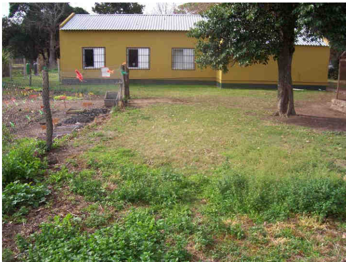
Figura 30 – vista frontal del sector donde fue instalado el biodigestor.
