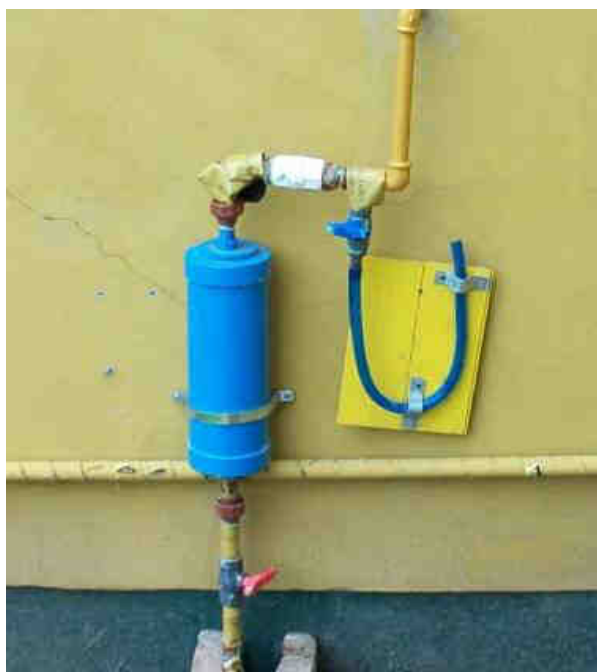
Figura 38 – Vista de trampa de llama, válvula de una sola vía y manómetro en U.
