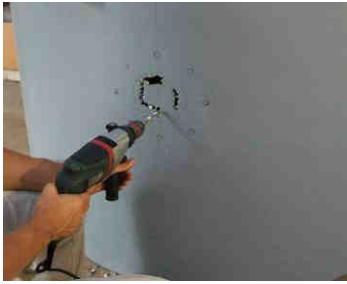
Figura 3 – Perforación en tanque.
