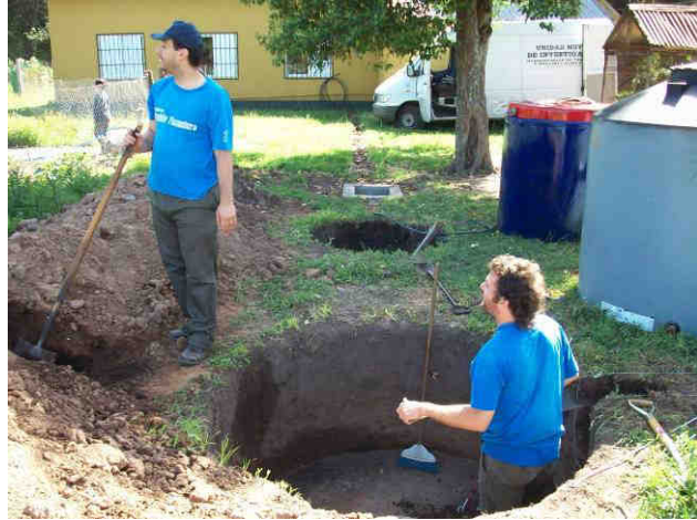
Figura 31 – Vista pozo de biodigestor (delante) y gasómetro (detrás).
