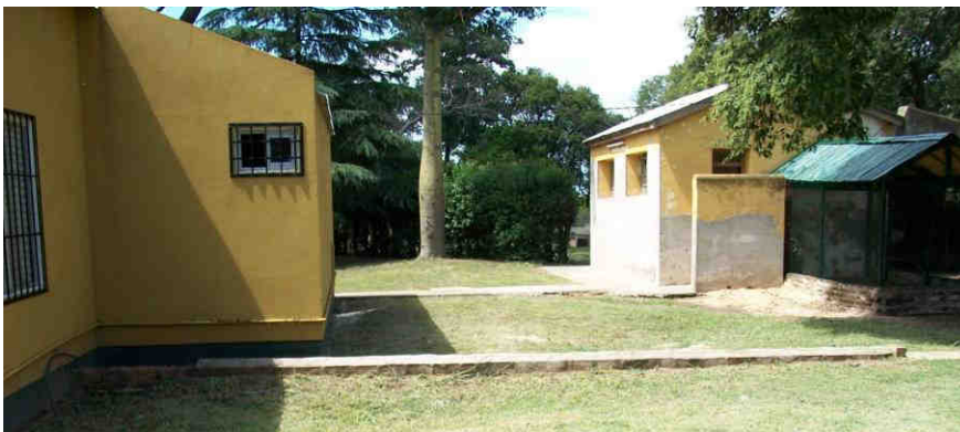
Figura 37 – Vista final: construcción de mampostería para protección de la cañería
