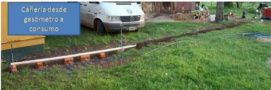
Figura 36 – Construcción de cañería de biogás. Vista de caño de PVC por donde se coloca la manguera plástica. Elevación de nivel
