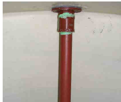
Figura 8 – Vista interna caño camisa. Parte superior del tanque
