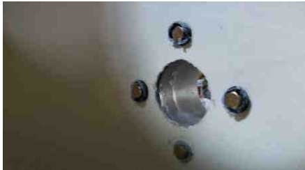
Figura 5 – Vista interna – bulones de fijación de la brida
