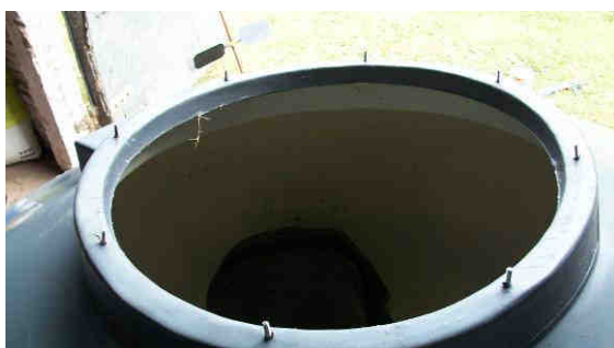
Figura 14 – Colocación de bulones en biodigestor
