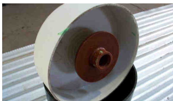
Figura 21 – Colocación de salida de tanque en tapa de PVC
