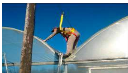
Trabajo en altura con uso de arnés.
