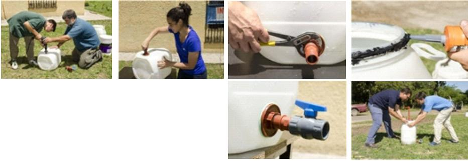
Realizamos dos orificios para colocar las salidas de fondo de 1" y fijamos con sellaroscas, las conexiones para el desagote y la salida del biol. Ajustamos con la ayuda de una llave. Para terminar, colocamos sellador en la rosca de la tapa y fijamos al cuerpo del reactor. Es muy importante sellar bien todas las uniones para evitar entrada de aire al reactor y pérdidas del sustrato, asegurando su buen funcionamiento.
