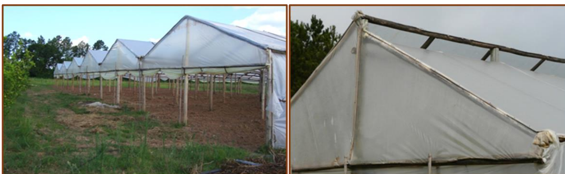
Figura 1: Invernadero tipo rancho y tipo chileno de 7 x 24 m, construcción típica en el departamento de Bella Vista. Fuente: Roberto Pacheco, INTA EEA Bella Vista
