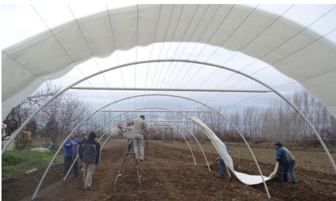
Taller de construcción de un Macrotúnel
