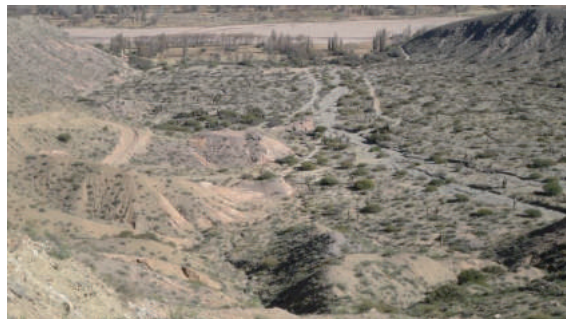
Vista panorámica del emprendimiento productivo comunitario. Se puede observar a ambos margen del río principal dos caminos construidos que se conectarán con el sector norte y sector sur. Entre los caminos y las laderas se encuentran distribuidas las 13 ha de riego presurizado en función de la gravedad.
