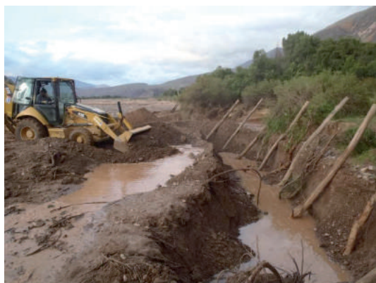
Figura 6. Construcción de defensivos de emergencia. Excavado de zanjas para el armado de defensas en base a troncos, ramas y alambre, durante la crecida de febrero de 2013. Foto: Juan Pablo Zamora Gómez.
