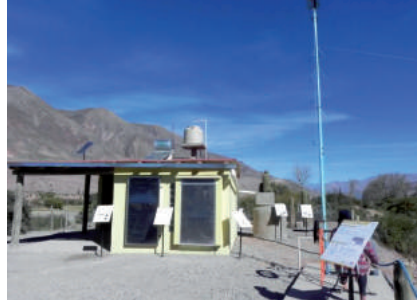
Figura 9. Vista del sector ampliado del CDT Hornillos.
