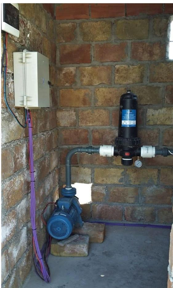
Figura 60. Electrobomba centrífuga trifásica en cabezal de riego por goteo, Pedro Luro.
