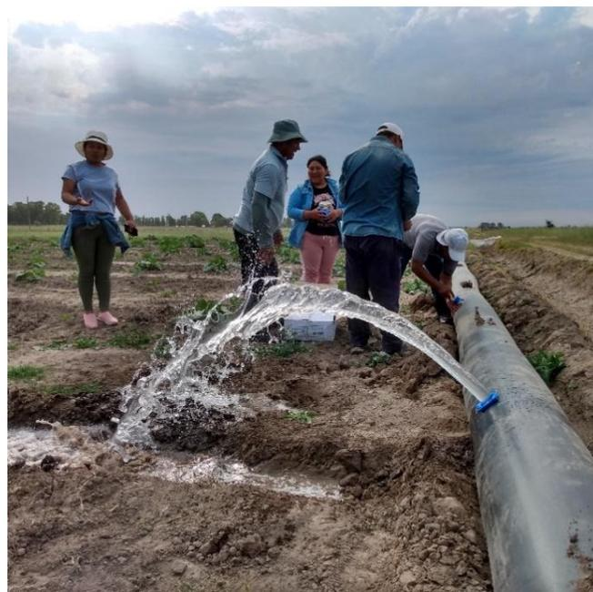
Figura 30. Instalación de compuertas de riego sobre una manga de polietileno para el riego por surcos, Pedro Luro.
