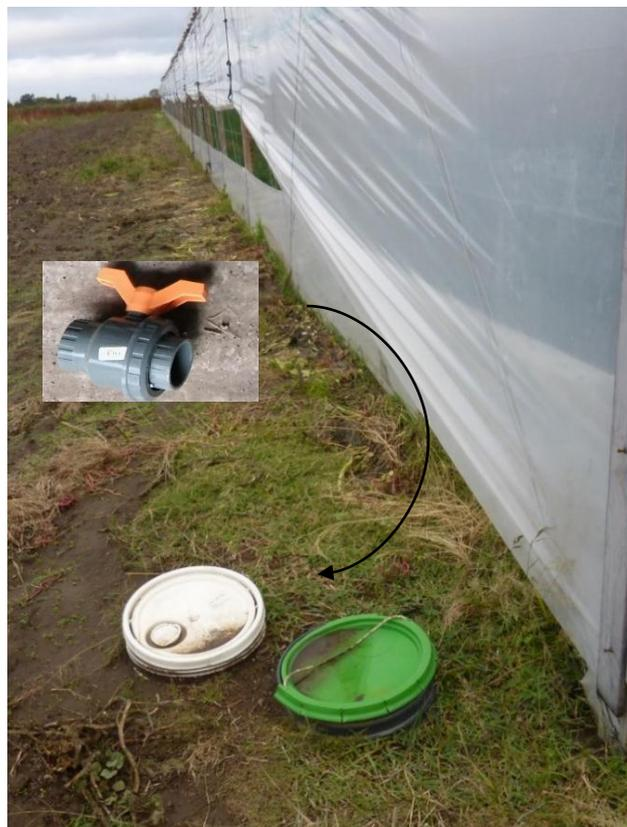
Figura 81a. Cajas hechas con baldes de 20 litros para las llaves de paso o válvulas de los sectores de riego, Juan A. Pradere.
