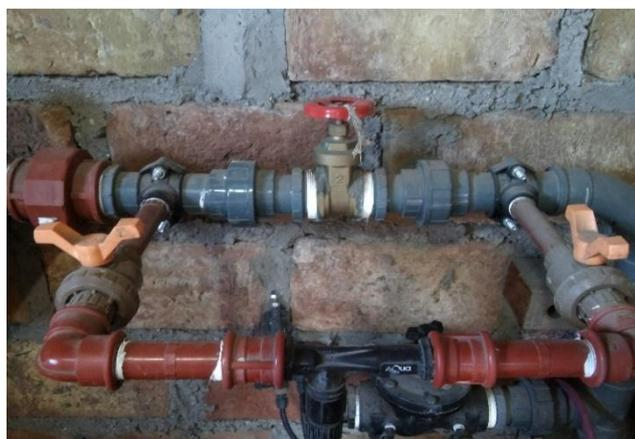
Figura 84. Venturi para la inyección de fertilizantes en cabezal de riego por goteo, Pedro Luro.
