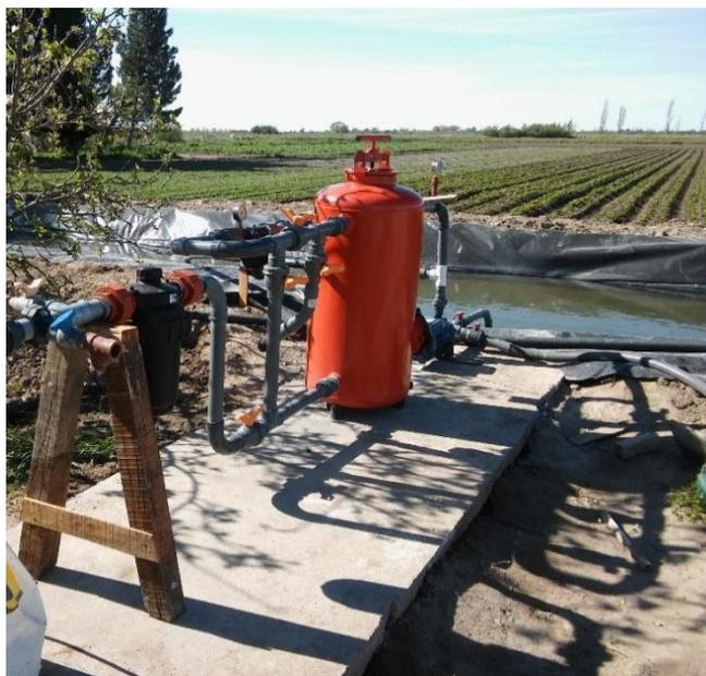
Figura 71. Armado de cabezal de riego por goteo con filtro de grava en Juan A. Pradere.
