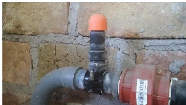
Figura 76. Válvula de aire en cabezal de riego, Pedro Luro.
