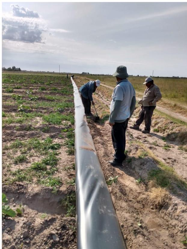
Figura 2. Preparación del terreno para la colocación de una manga de polietileno, Pedro Luro.
