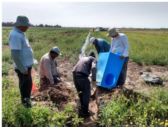
Figura 3. Toma de agua en acequia con tacho de PVC, Pedro Luro.
