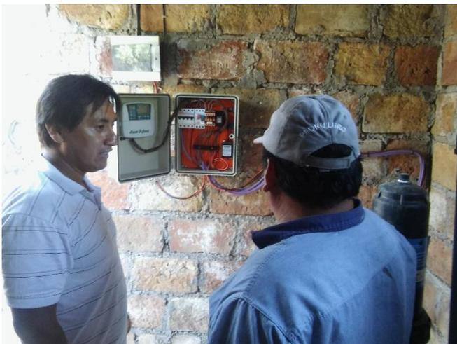
Figura 95. Programador o controlador de riego de seis zonas en un equipo de riego por goteo, Pedro Luro.
