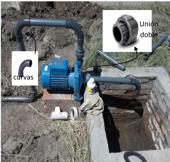
Figura 78. Curvas y uniones dobles en el armado de un equipo de riego, Juan A. Pradere.
