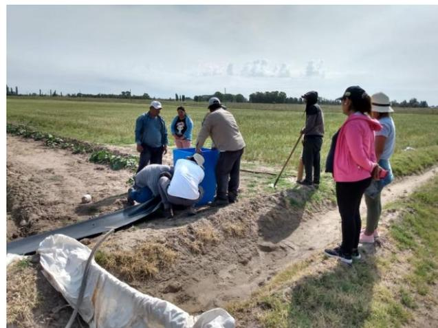
Figura 33. Colocación de tambor plástico en un manga de riego de 12 pulgadas y 200 micrones, Pedro Luro.
