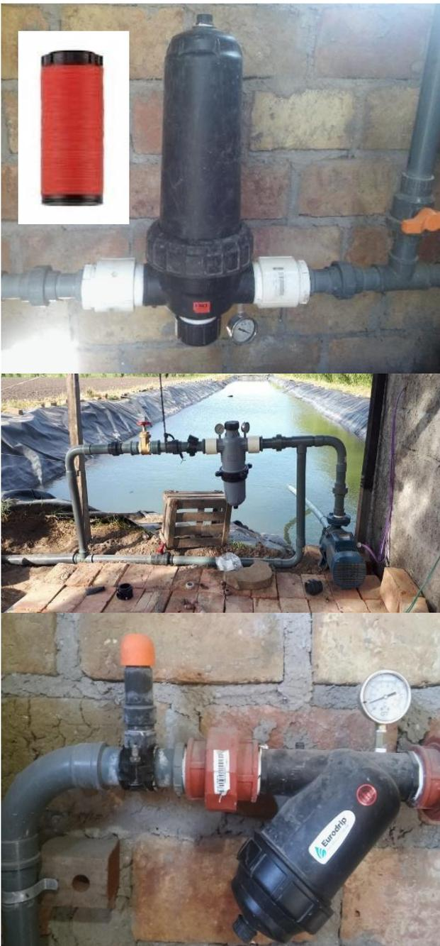
Figura 68. Cabezales de riego por goteo con filtro de anillas, Pedro Luro.
