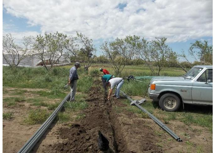
Figura 74. Conducción de agua a través de tuberías de PVC en equipo de riego por goteo, Pedro Luro.
