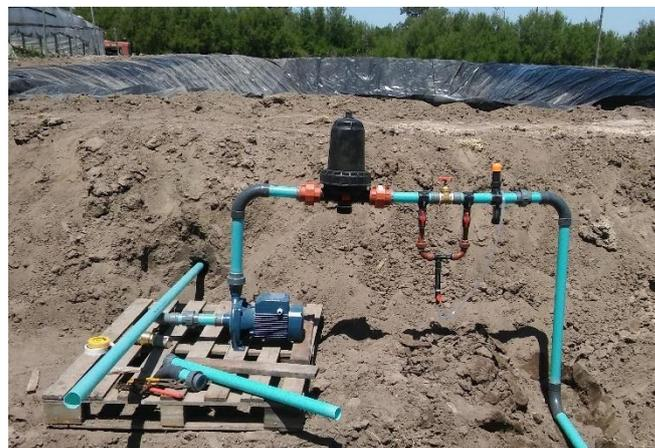
Figura 85. Armado de cabezal de riego con sistema de fertilización Venturi, Juan A. Pradere.
