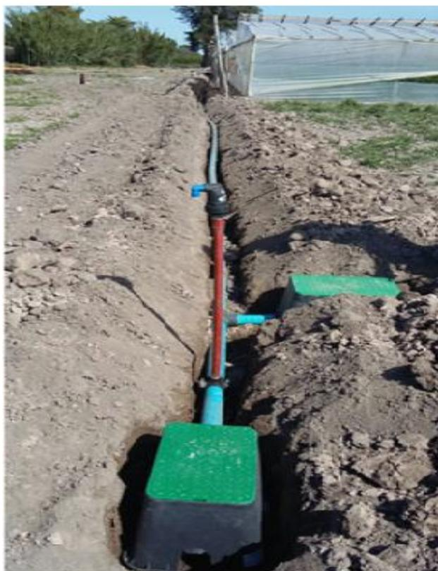
Figura 81b. Caja rectangular de polipropileno para válvulas de riego o cualquier elemento que requiera inspección, Pedro Luro.
