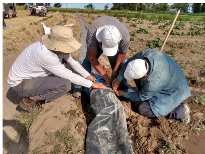
Figura 34. fijación de la manga a una cupla plástica con un trozo de cámara vieja, Pedro Luro.
