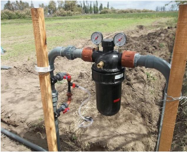
Figura 100. Manómetros en el ingreso y salida de agua del filtro de anilla, Juan A. Pradere.
