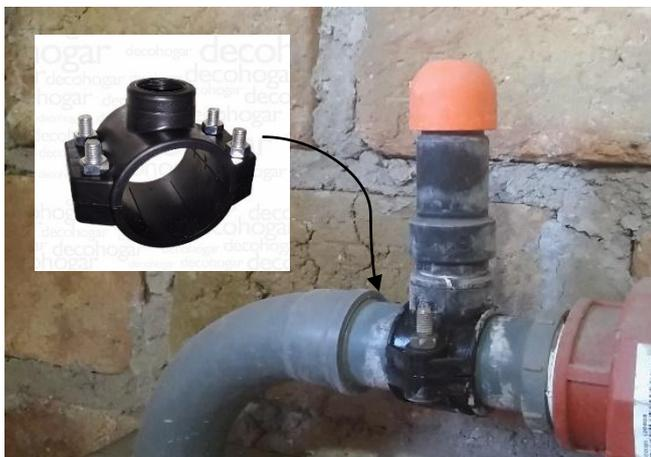
Figura 83. Montura sobre caño de PVC, para colocar una válvula de aire en un equipo de riego por goteo, Pedro Luro.
