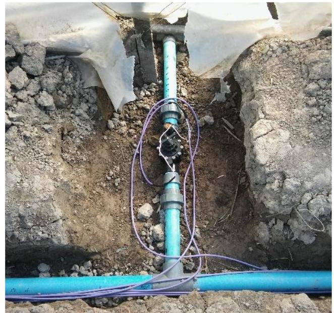
Figura 97. Válvula solenoide de apertura y cierre de un sector de riego instalada en un sistema de riego en invernadero, Pedro Luro.
