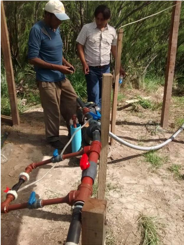
Figura 52. Toma de agua de perforación y del río para riego por goteo en invernaderos, Hilario Ascasubi.
