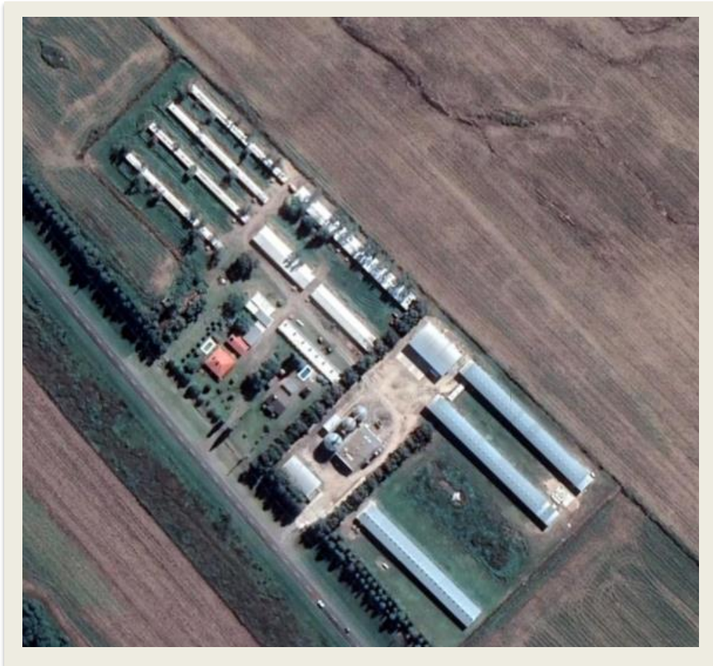
FIGURA 10. Distribución estructural de un EP de huevos con sistema manual y automático de producción. Fuente: elaboración propia
