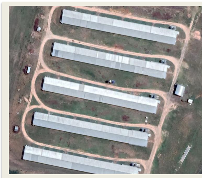
FIGURA 13. Distribución estructural de un EP de pollos parrilleros con sistemas “black out” o de laterales cerrados. Fuente: elaboración propia
