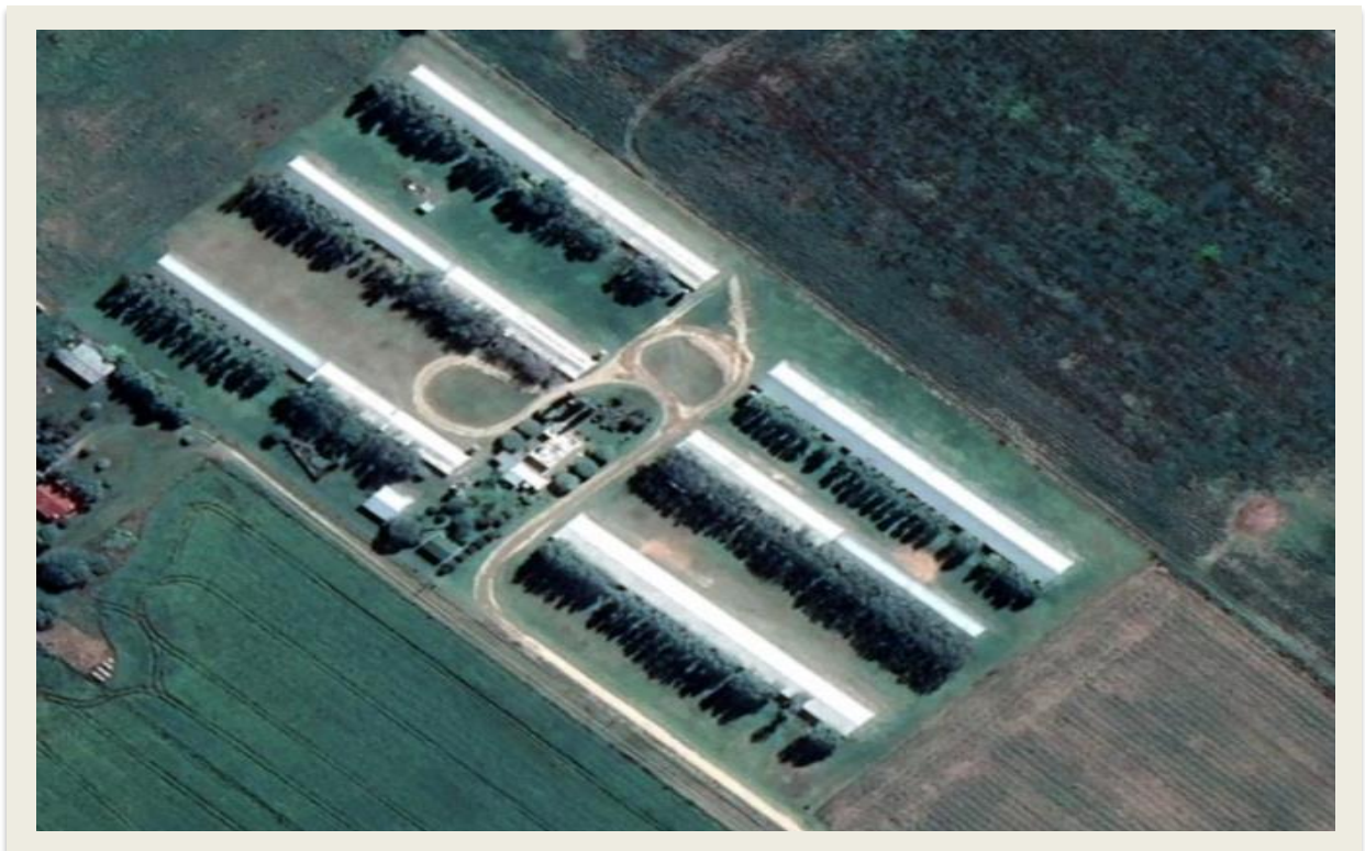
FIGURA 9. Distribución estructural de un EP de huevos con sistema manual de producción. Fuente: elaboración propia
