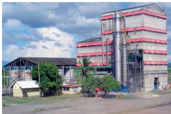
Figura 4.14. Destilería de etanol de CATSA (Costa Rica)
