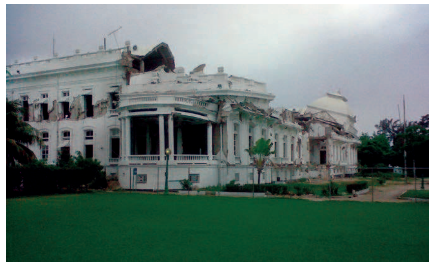
Foto: Palacio Presidencial luego del terremoto. Foto: D. Diaz
