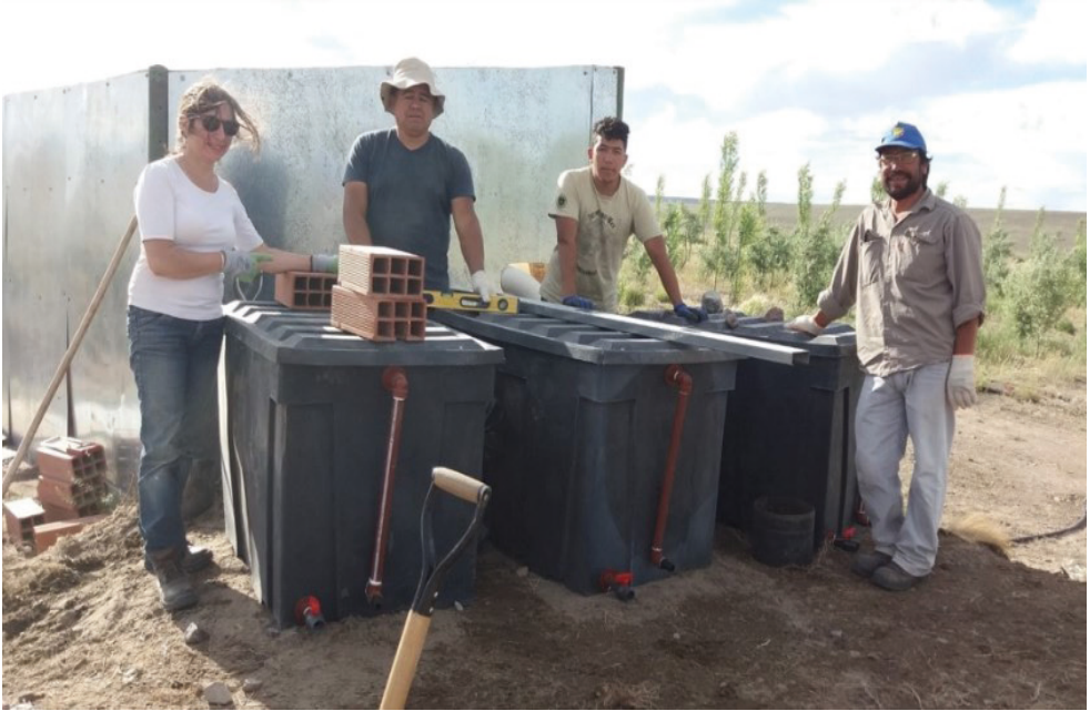
. Construcción e instalación de filtros a campo; tanques de 400 litros con sus respectivas conductos para la salida de agua residual tratada filtrada.
