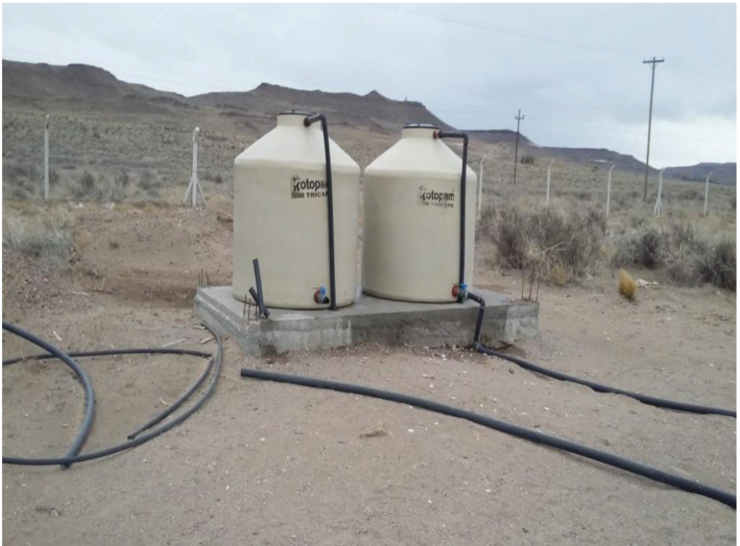
. Tanques reservorios de agua de perforación y agua tratada
