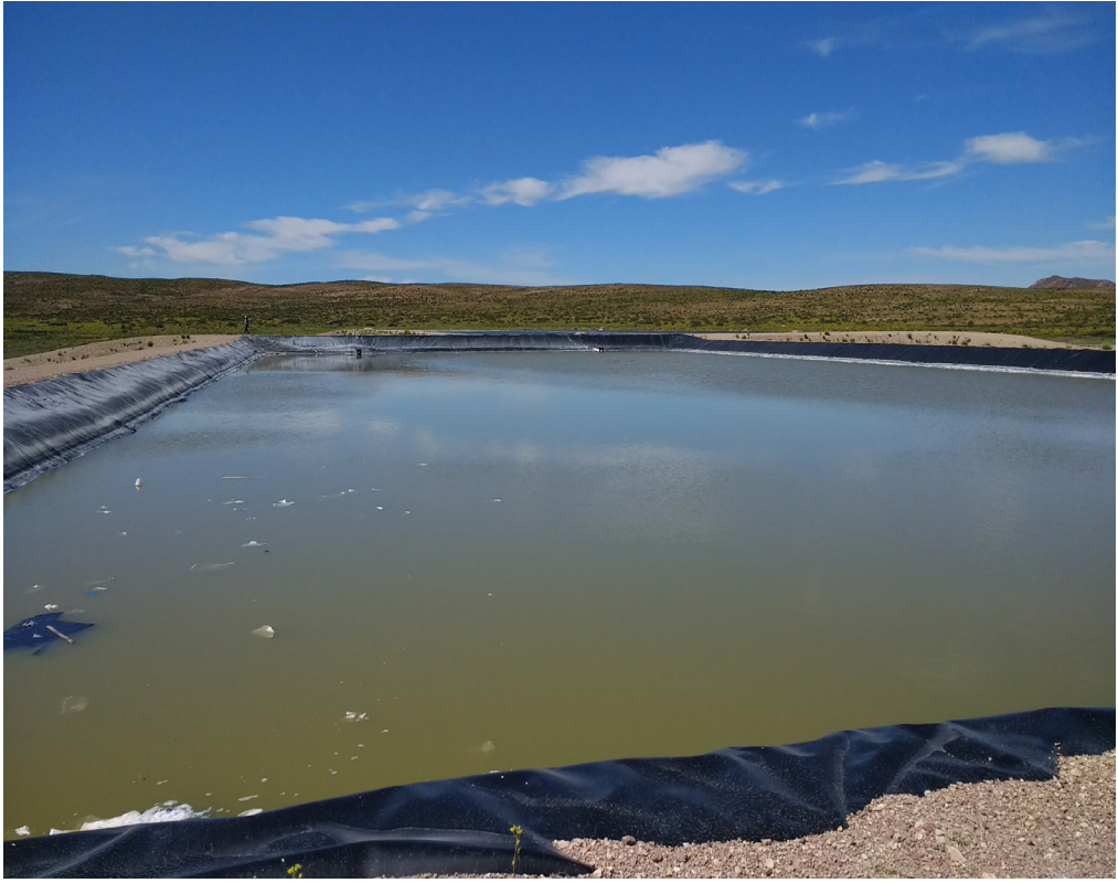
. Vista de la Planta de Tratamiento de Líquidos Cloacales
