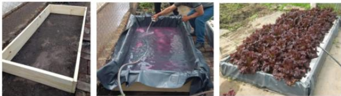
Figura 3.5: Etapas en la construcción de una pileta individual de cultivo de raíz flotante
