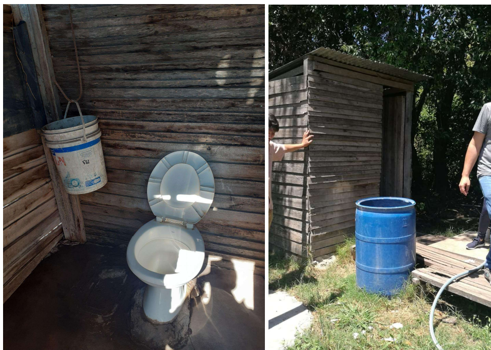
Figura 2. Instalaciones sanitarias fuera de las viviendas en las quintas.
