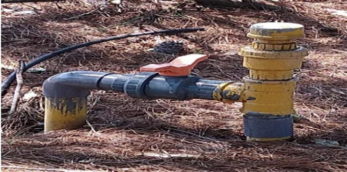
Figura 11. Cabezal de campo con válvulas hidráulica y de aire.
