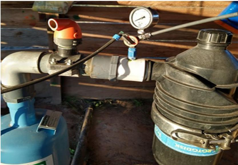
Figura 9. Válvula de Aire y Manómetro en cabezal de riego.
