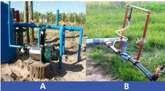
Figura 10. Cabezal de riego con sistema de fertirriego: a) bomba centrífuga, con carcasa de acero inoxidable y b) Venturi con flujometro, para regular caudal
