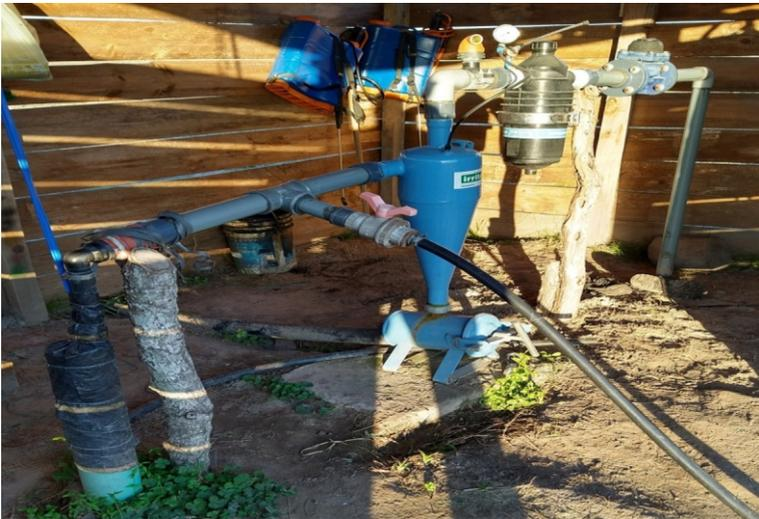
**Figura 7. Cabezal de riego con abastecimiento de agua de perforación profunda, bomba sumergibles, sistema de filtrado para arena (hidrociclón), filtro de anillas, válvula hidráulica, contador volumétrico, válvulas de aire y manómetro.**
