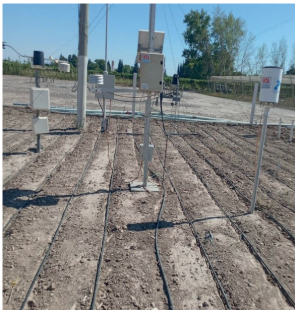
Figura 28. Riego por goteo subterráneo en la estación meteorológica del INTA San Juan, previo al tapado de las mangueras Fuente: Alfredo Olguín
