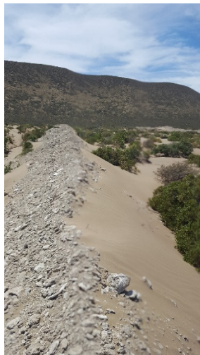
Fotos 5, 6 y 7: Detalle del trabajo de apertura de zanjas y cobertura del entresurco con conchilla.
