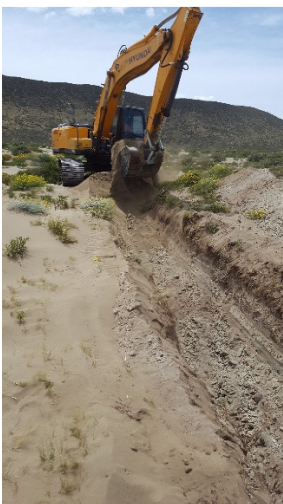
Fotos 5, 6 y 7: Detalle del trabajo de apertura de zanjas y cobertura del entresurco con conchilla.
