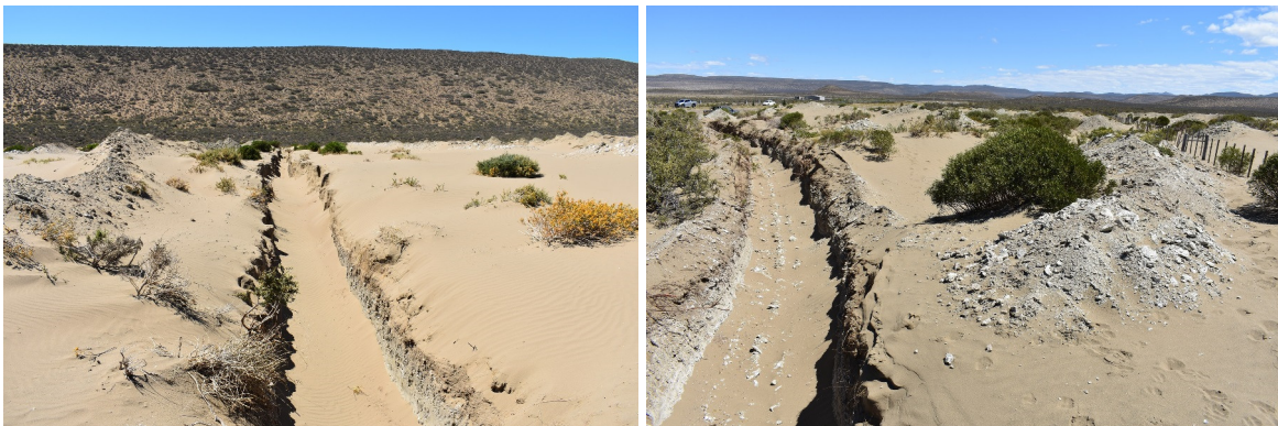
Fotos 15 y 16: Surcos todavía con capacidad de retener material erosivo.
