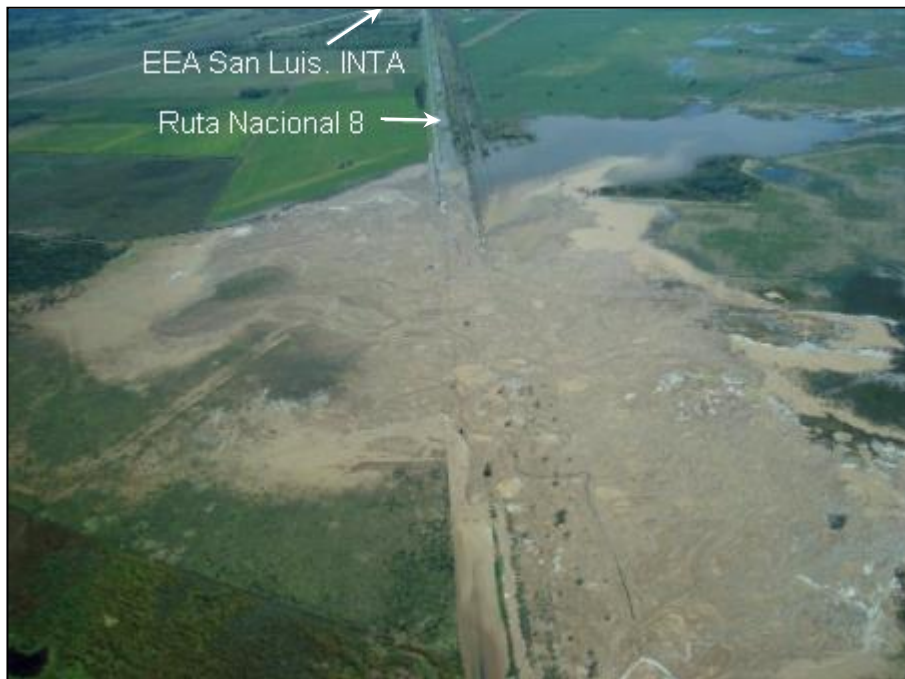
Figura 10: Sedimentos sobre la Ruta Nacional 8 próximo a Villa Mercedes
