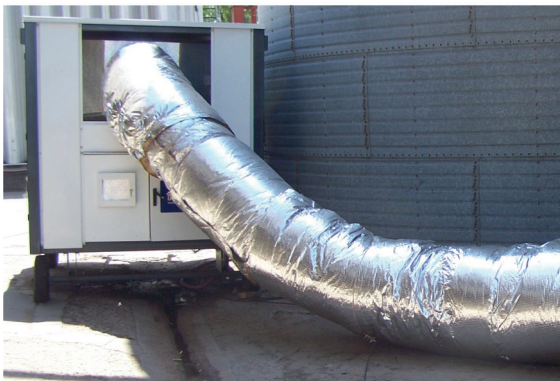
Figura 15. Escurrimiento del agua proveniente del refrigerador a través de un canal ya conformado.
