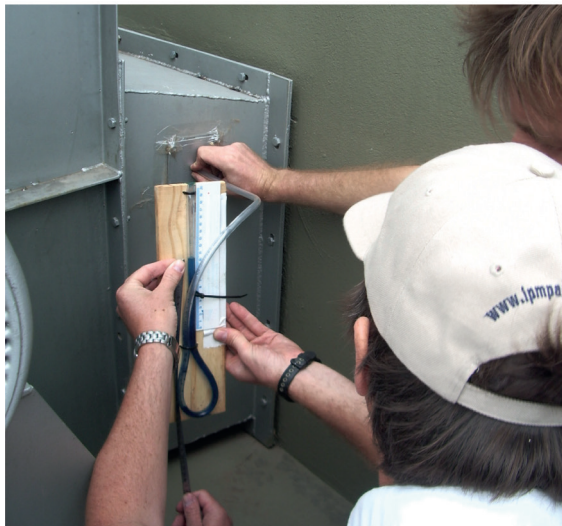
Figura 12. Medición de la presión estática en la transición de ingreso de aire al silo con manómetro diferencial de columna de agua.
