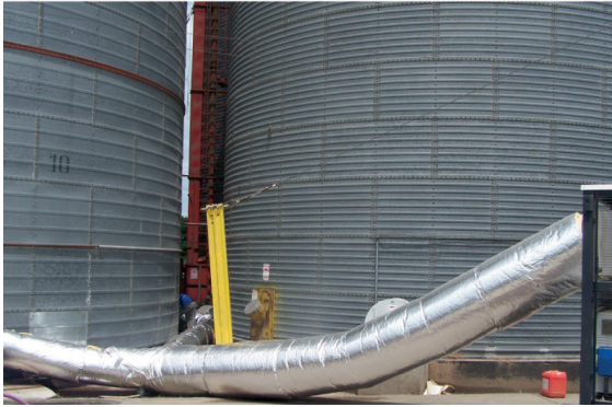
Figura 7. Conexión del equipo de frío a las 2 bocas de aireación de un silo.
