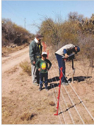
Instalación de boyero en la localidad Esquina del Norte.
