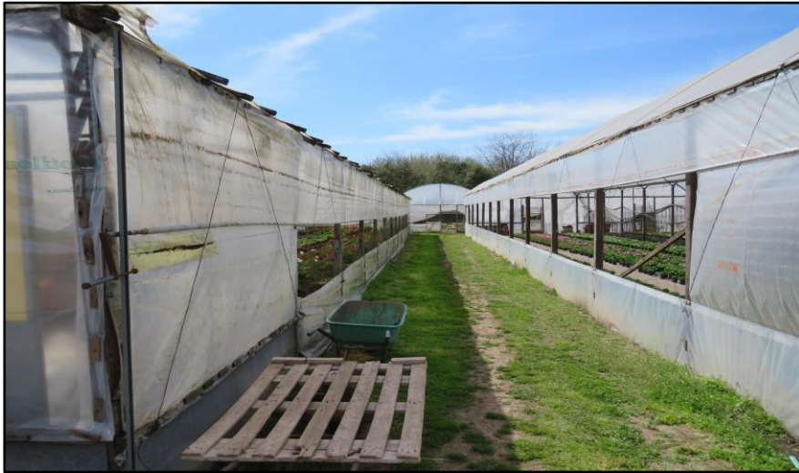
Figura 6. Recubrimiento con polietileno y vidrio, ventilación natural a través de ventanal (A) cenital y (B) lateral del E2.
