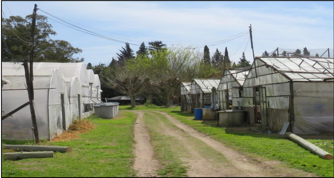
Figura 5. Tipo de invernáculos del Establecimiento N°2: estructura de madera con techo de vidrio a dos aguas y estructura parabólica metálica.
