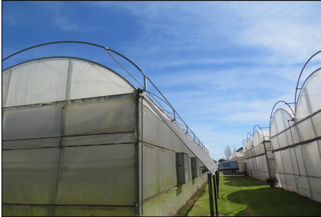
Figura 8. Invernáculos del tipo macrotúnel con estructura de metal y cubierta de polietileno perteneciente al E3.
