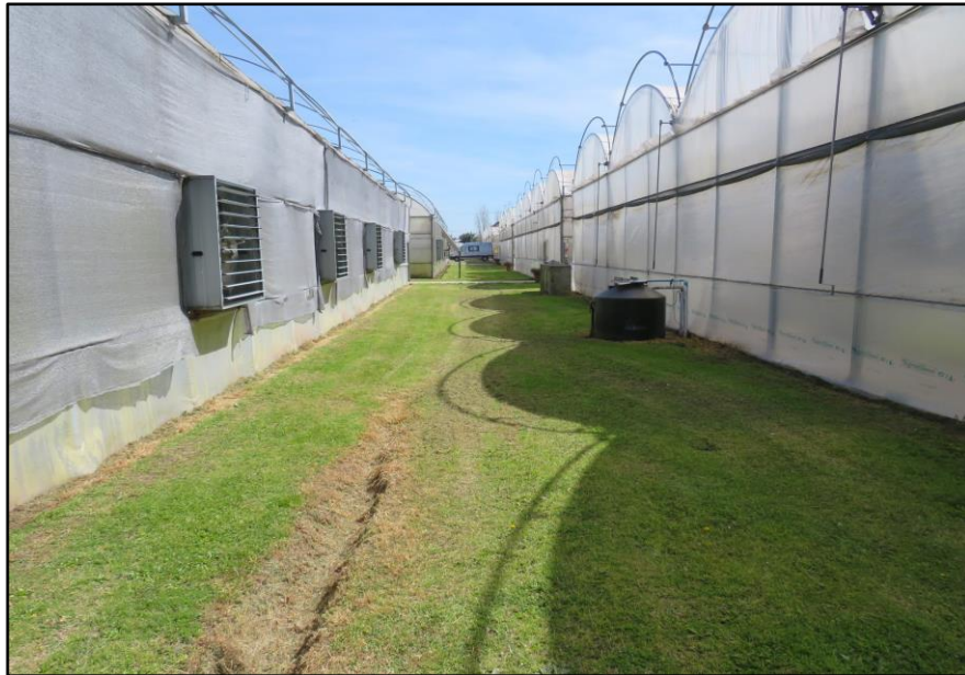
Figura 9. (A) Panel refrigerador Cooling System. (B) Estructura metálica sobre la cubierta de polietileno para la colocación de la malla de sombreado en el predio del E3.
