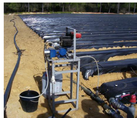
Fig. 10 Inyección de bromuro de metilo en la línea de goteo.
