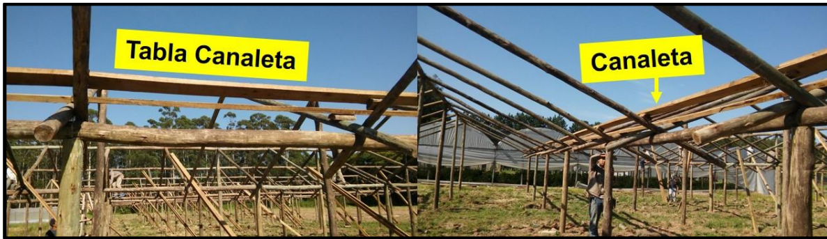
Figura 32. Ubicación de las tablas para canaleta
