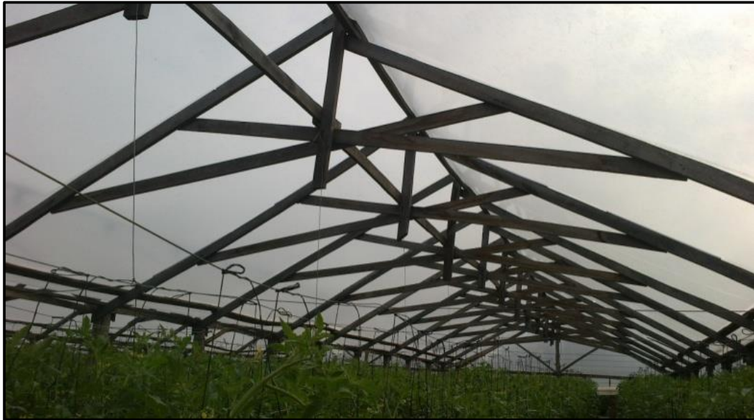
Figura 30. Cabriada de madera aserrada
