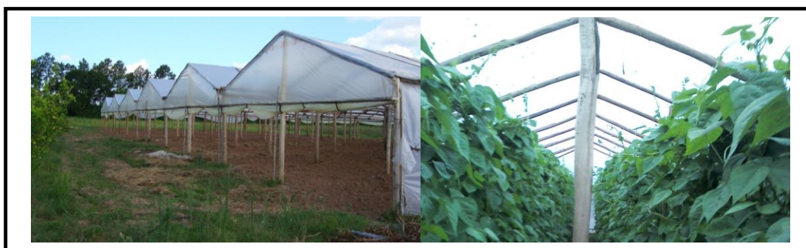
Figura 1. Capilla a Dos Aguas o “rancho”
