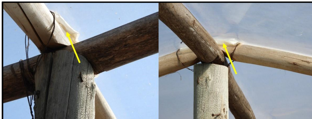
Figura 47. Refuerzo de plástico en uniones para evitar desgarró del polietileno
