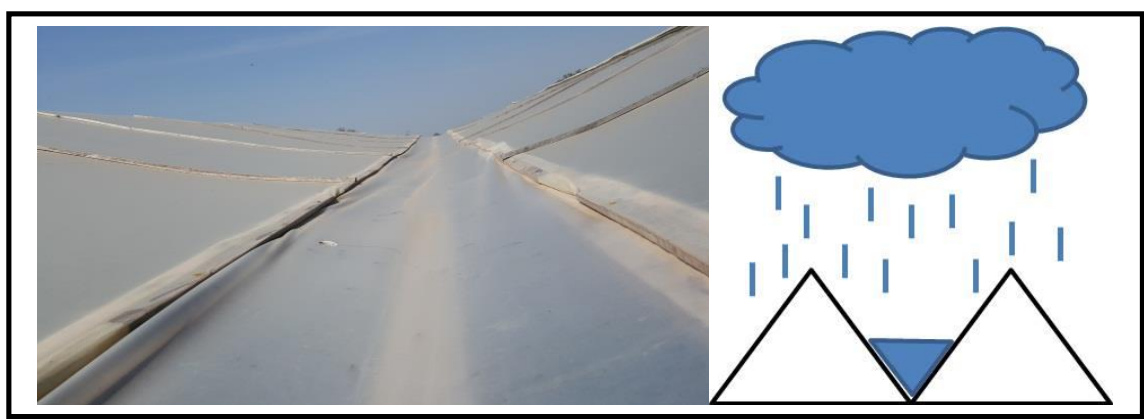
Figura 6: Canaleta. a) vista de arriba; b) función. Foto: Mario Lenscak
