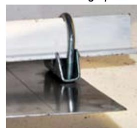
Detalle de la sujeción del cartel de chapa galvanizada
