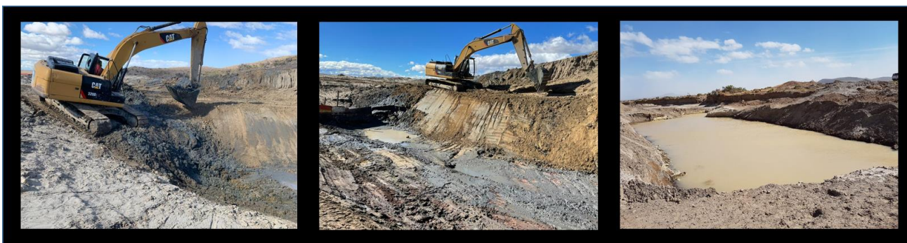
Foto 6. Construcción de tajamar aprovechando un cañadón natural. (Ea Cerro Guacho Depto Escalante, fotos gentileza Productora Susana Perujo)
