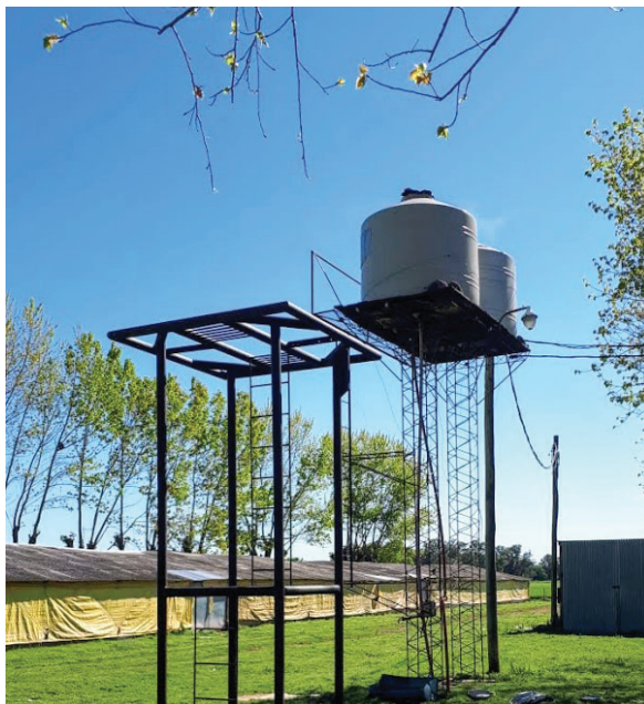
Figura 11: Perforación de agua
