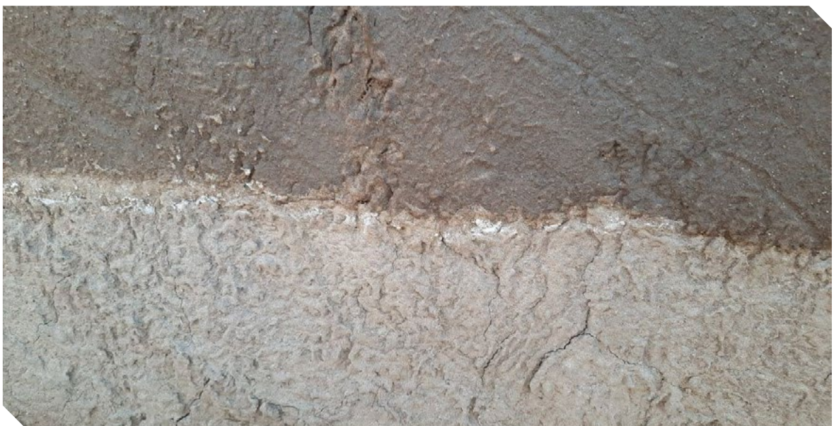
▲ Figura 26. Deposición de sales poco solubles (carbonatos) en el frente de ascenso capilar.
