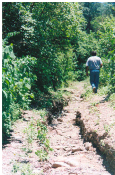
Foto N° 2: Construcción de vías de saca. Erosión por surcos en áreas con pendiente.
