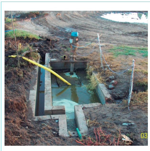
Foto 3. Pozo de bombeo de efluentes. Sector de monitoreo en canaleta de ingreso.
