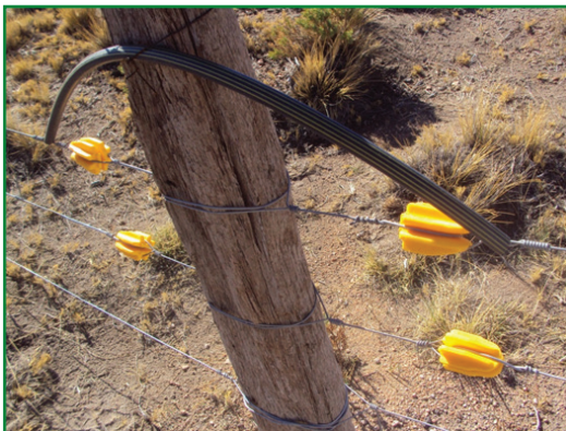
Imagen 15: La manguera protege al cable que lleva la corriente para que no se descargue al pasar a través del poste. Esta manguera está curvada hacia abajo para que no se le acumule agua de lluvia en su interior. Para el alambre que lleva la puesta a tierra no es necesaria la manguera pero si es necesaria la unión de los alambres a través del poste.
