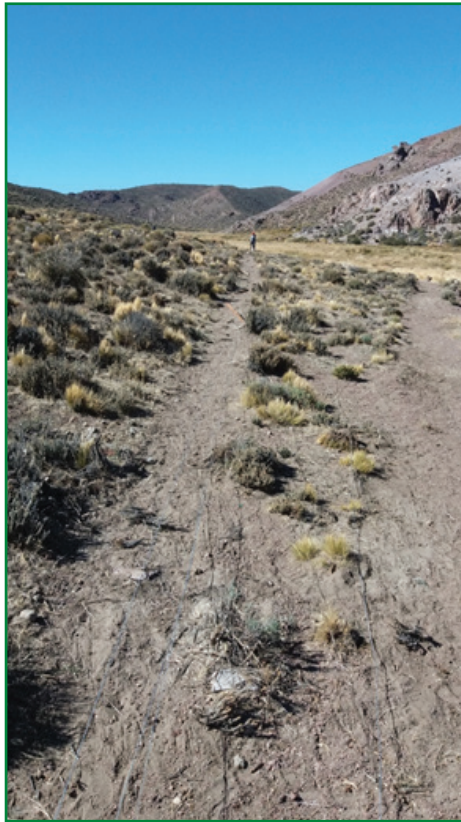
Imagen 29: Faja de 40 cm o más para evitar que los alambres "vivos" se descarguen al tocar la vegetación.
