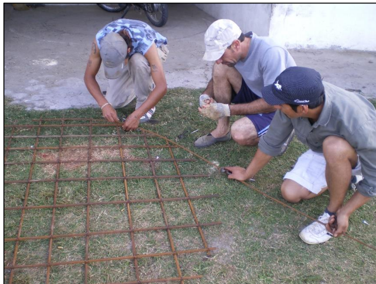
Figura 22: Jóvenes de la comunidad capacitándose en el armado de la parrilla de la losa inferior del aljibe.
