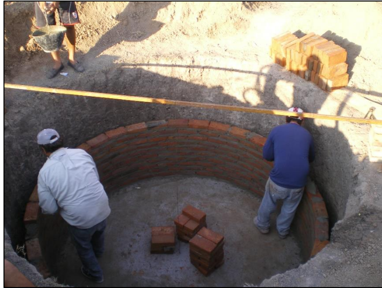
Figura 27: Levantando las paredes del aljibe.
