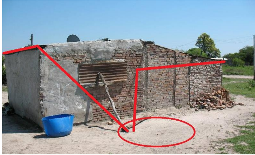
Potencial ubicación del aljibe en la zona este de la casa
