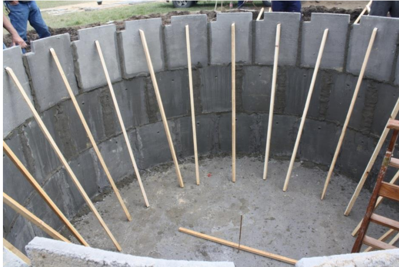
Figura 14: Construcción de aljibe de placas de cemento (Fuente: Ing. Mario Basán Nickisch).
