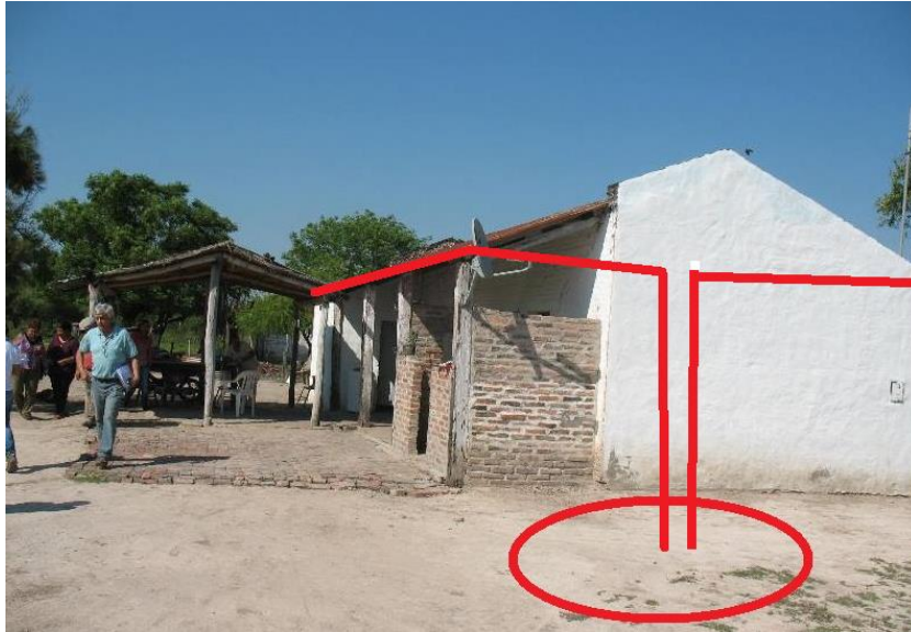
Ubicación del aljibe en la zona norte de la casa
