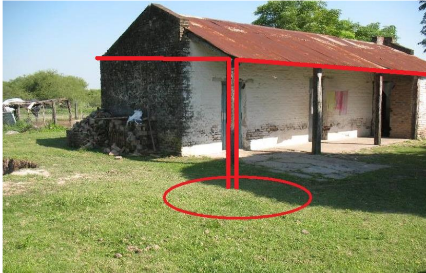
Ubicación del aljibe en la zona sureste de la casa
