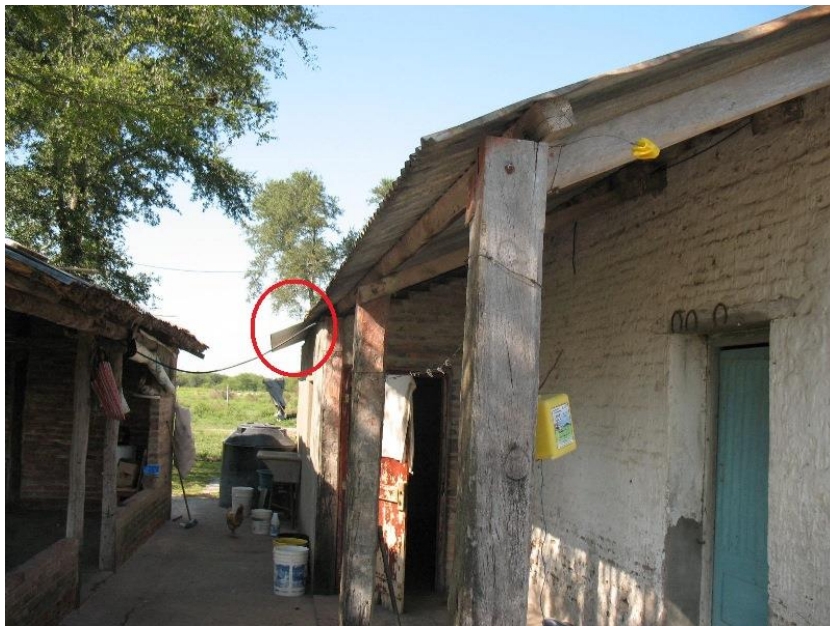
Chapas a emparejar de los 2 lados para colocar de manera correcta las canaletas.
