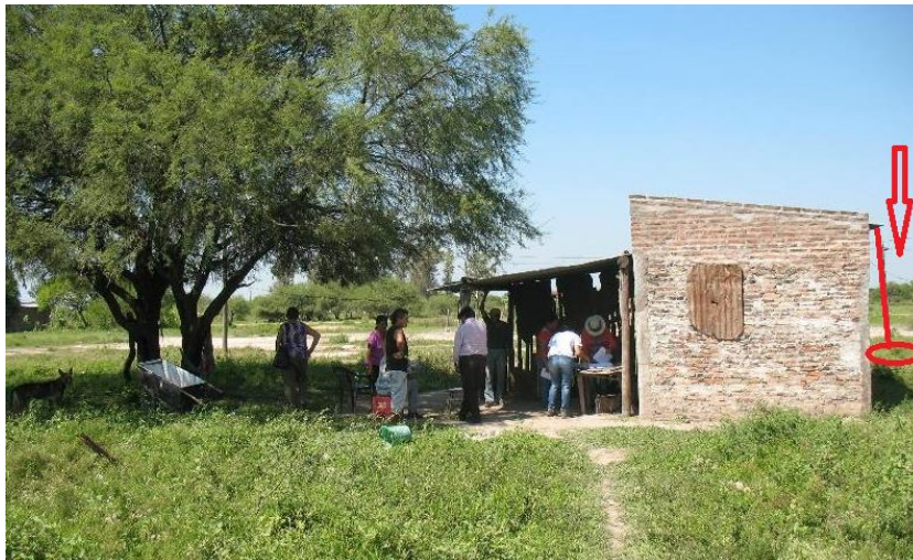
Ubicación del aljibe en la zona suroeste de la casa.
