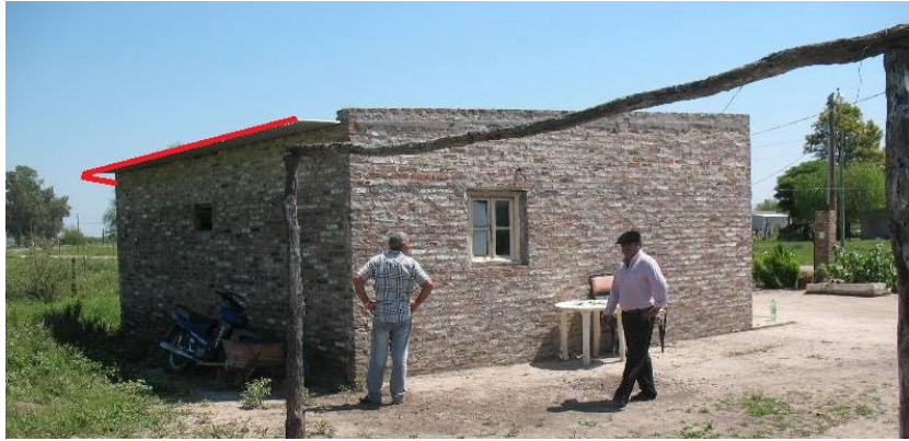
Ubicación del sistema de canaletas en la parte sur de la casa.
