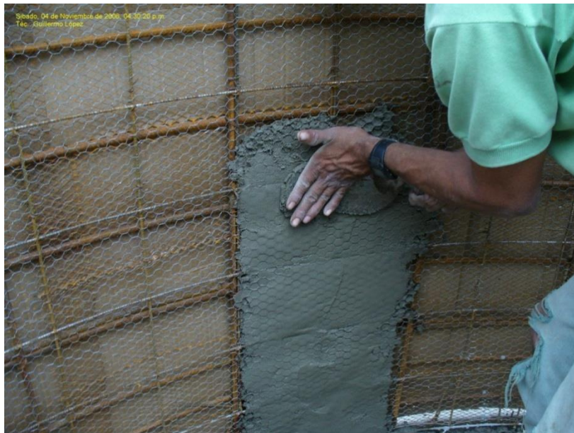
Figura 13: Construcción de aljibe de ferrocemento (Fuente: Subsecretaría de Desarrollo Rural y Agricultura Familiar).
