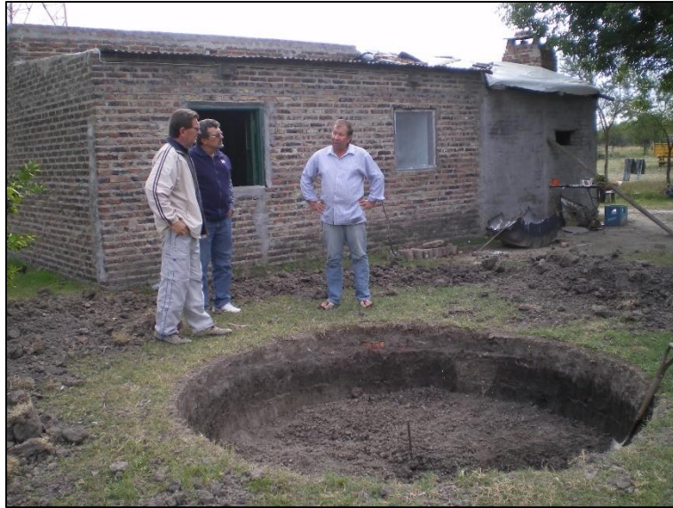
Figura 25: Técnicos de FUNDAPAZ e INTA junto con el jefe de hogar analizando el avance de la excavación para la construcción de su aljibe.
