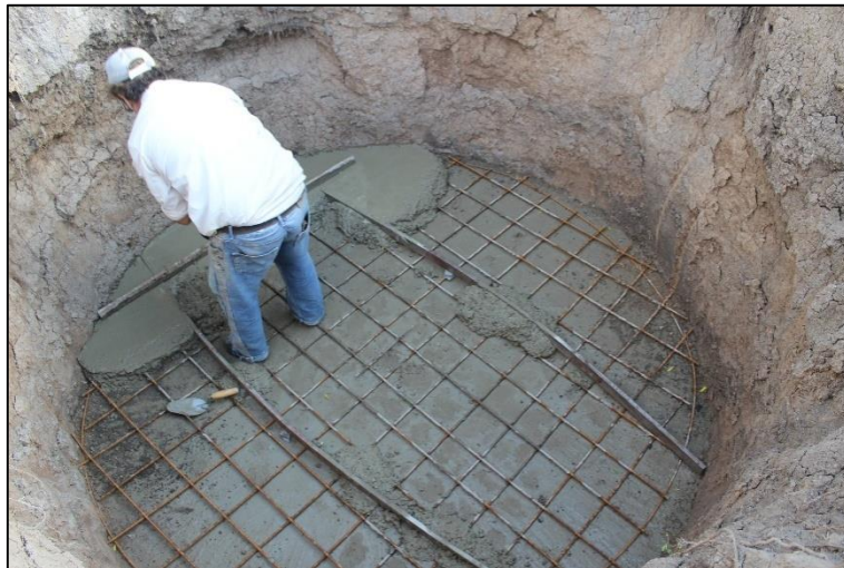
Figura 26: Construyendo la losa inferior del aljibe.
