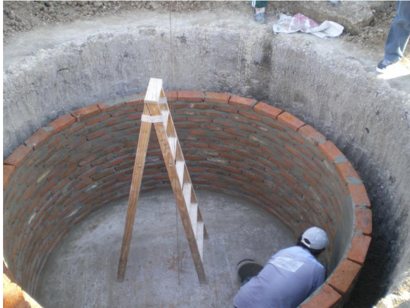
Figura 12: Construcción de aljibe de mampostería (Fuente: Ing. Mario Basán Nickisch).
