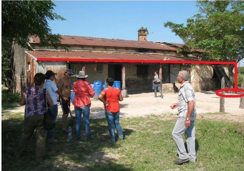
Ubicación del aljibe en la zona noroeste de la casa
