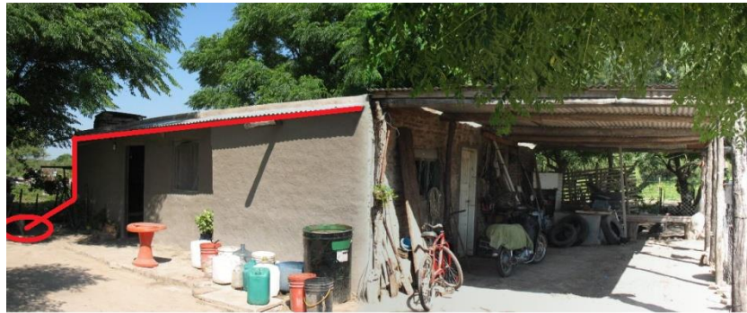
Ubicación del aljibe en la zona sureste de la casa. Zona con raíces de árboles que hay que contemplar para que no afecte la estructura del aljibe.
