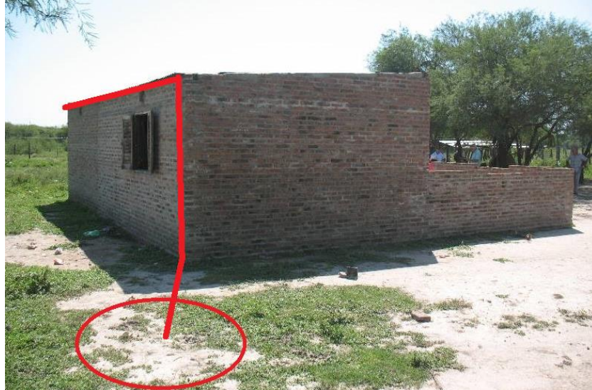
Ubicación del aljibe en zona suroeste de la casa
