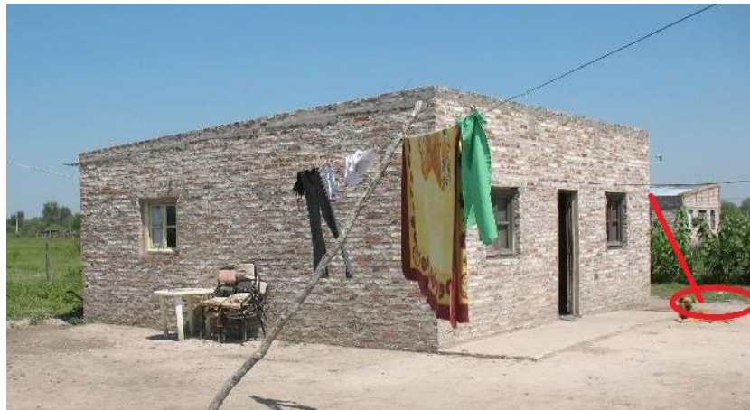
Ubicación del aljibe en la zona noroeste de la casa, estando las canaletas en la zona sur.
