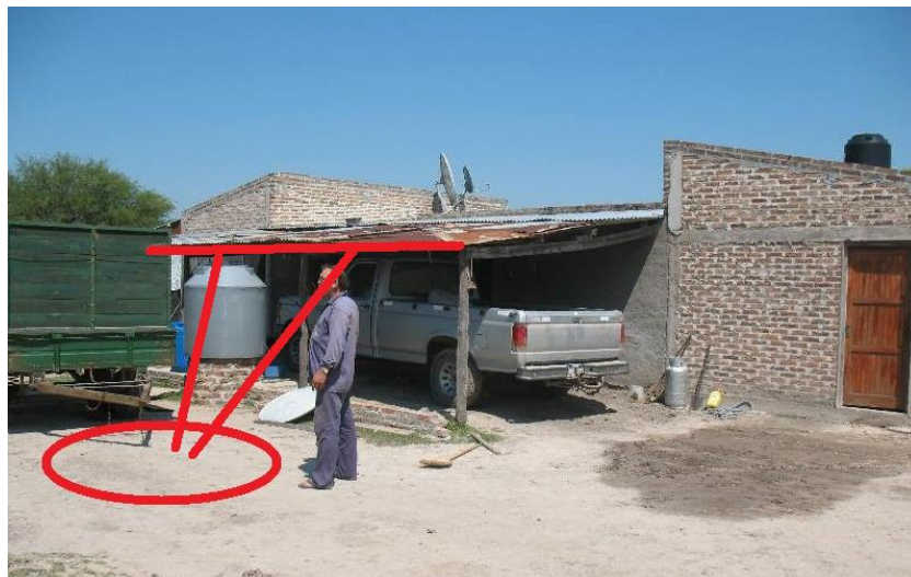
Ubicación del aljibe en la zona este de la casa.
