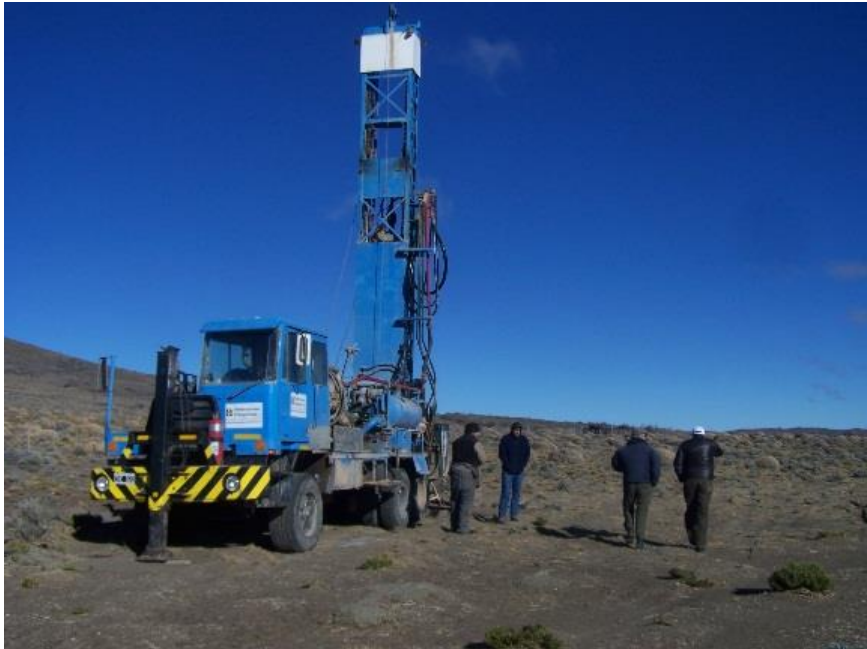
FIGURA 2: EQUIPO DE PERFORACIÓN
