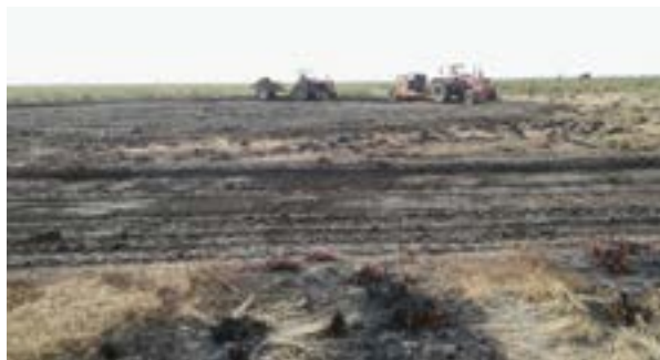
Inicio de obra.
