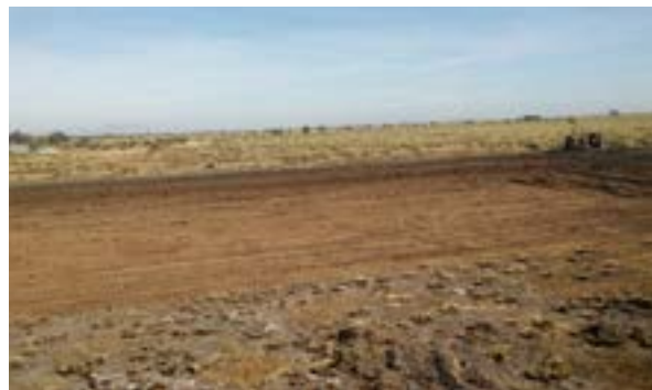
Represa recién terminada cuya tierra se ocupó para hacer el tanque de tierra
