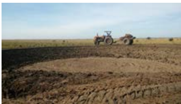
Vista del tanque construyéndose en su fase terminal.
