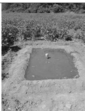
Foto 3. Preparación del terreno para la determinación de la capacidad de campo in situ . a) Construcción de la pileta de tierra; b) Pileta llena de agua.
