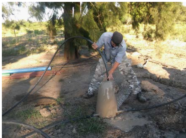
Fig. 2 Limpieza interior del encamisado y del filtro
