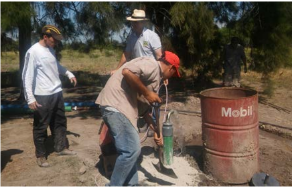
Fig. 3 Cementado de la perforación en superficie
