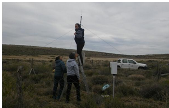
Izquierda instalación de Estación Meteorológica Davis Vantage Pro 2, derecha: reparación de Antena Estación Meteorológica Nimbus THP.
