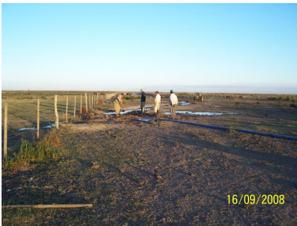
Figura 14. Realización de canales corta-fuegos en suelos orgánicos e incorporación de agua a lagunas internas de islas en situaciones críticas de falta de agua y cortafuegos. Fotos: Isla San Felipe – Dpto. Victoria. Año 2008.
