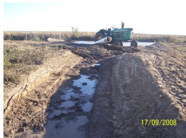
Figura 14. Realización de canales corta-fuegos en suelos orgánicos e incorporación de agua a lagunas internas de islas en situaciones críticas de falta de agua y cortafuegos. Fotos: Isla San Felipe – Dpto. Victoria. Año 2008.
