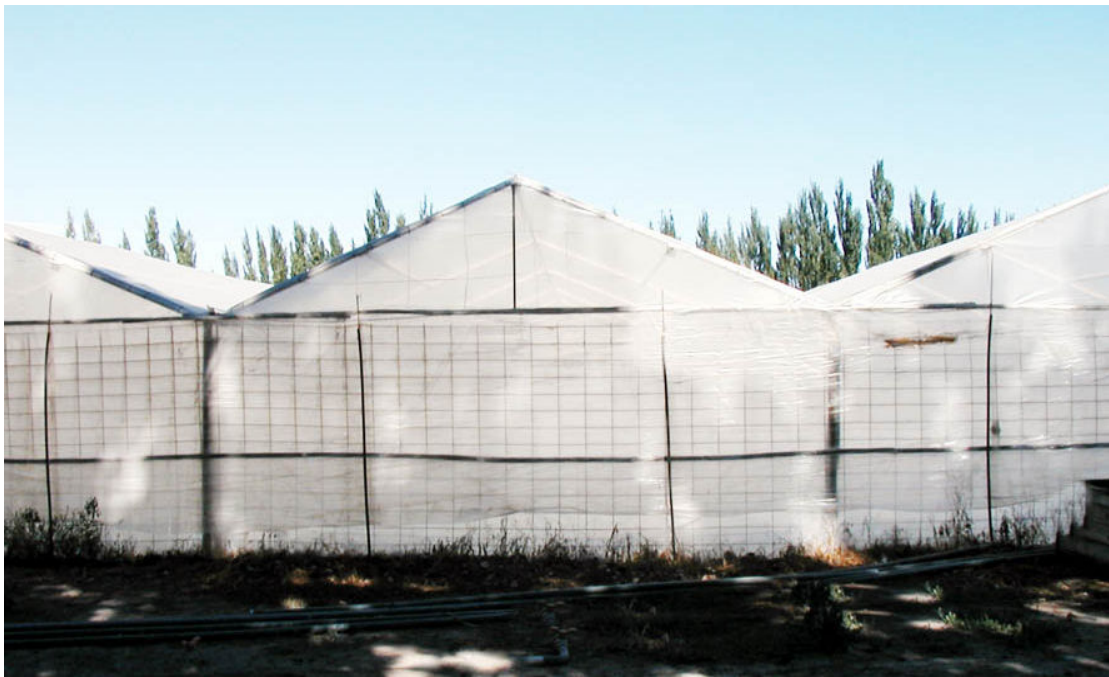
Figura 4.3. Invernadero metálico triple capilla de techo simple. Alto Valle de Río Negro- Patagonia-Argentina.
