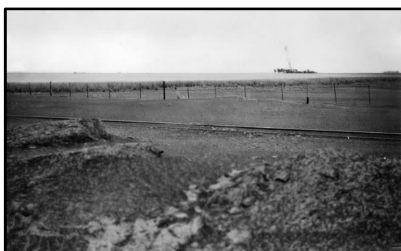
Figura nº 27. Sector erosionado entre Hilario Ascasubi y Mayor Buratovich (1948)
