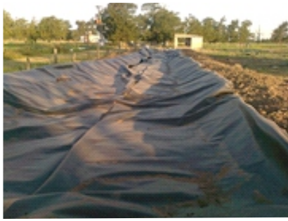
Geomembrana para tratamiento de efluentes - Las Breñas.
