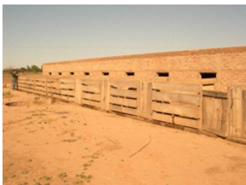
Batería de parideras mampostería - Concepción Bermejo - Chaco.
