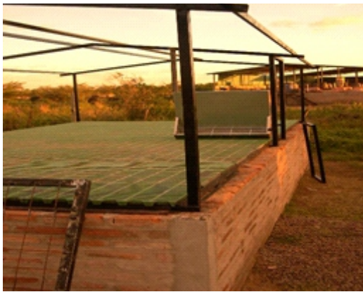
Base del módulo de destete - Corrientes.
