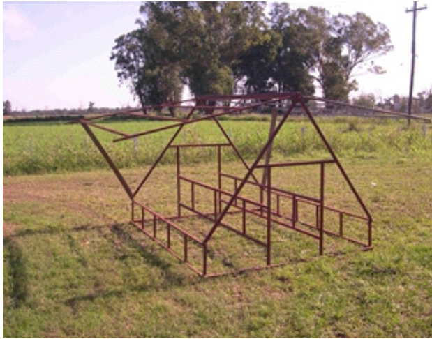
Estructura de base de la Paridera de campo tipo alpina, con techos levadizos, brete de parto y reparo de lechones - Las Breñas - Chaco.
