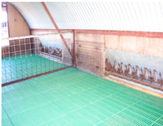
Box individual (por banda) de destete - Vacío sanitario.
