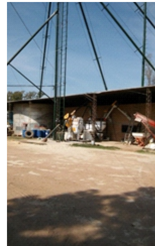
Planta de alimento balanceado - noria y sistema de carga y descarga desde mecanizada de forraje - Concepción del Bermejo - Chaco.
