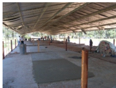
Pista de terminación en construcción - Concepción Bermejo - Chaco.
