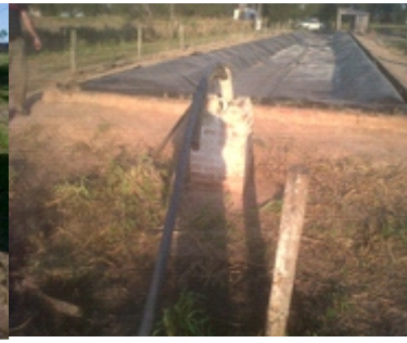
Tratamiento de efluente - geomembrana con anclaje en los bordes - Las Breñas.
