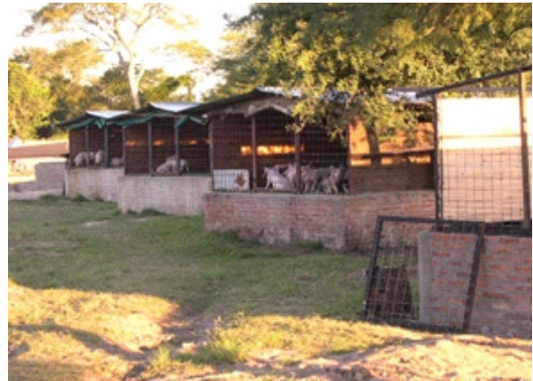
Módulos de destete individuales - piso eslat - hierro estructural y madera - chapa de cinc – Capacidad 80 lechones por módulo - Corrientes.
