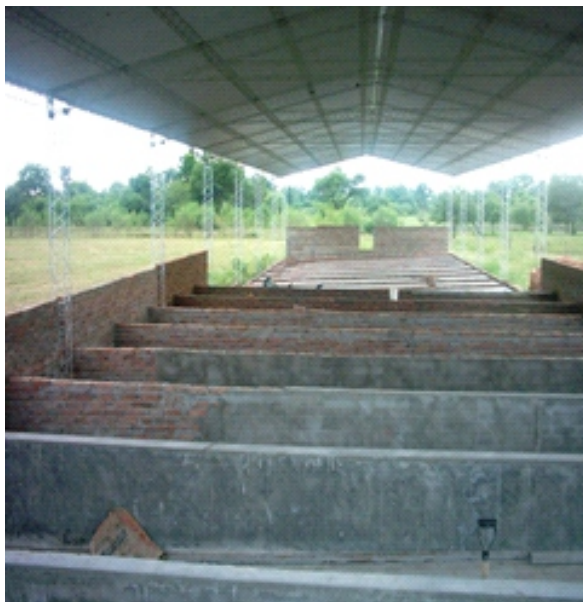
Galpón de engorde - piso de eslat – en construcción - Sáenz Peña – Chaco .
