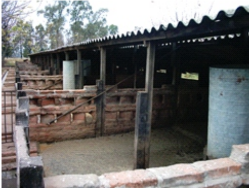
Boxes de destete- piso cemento - techo fibrocemento - Las Breñas - Chaco.
