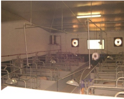
Maternidad con paneles humificadores y extractores - General Vedia - Chaco.
