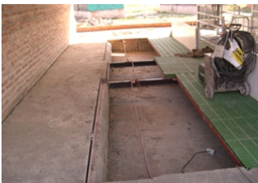
Maternidad - ilustra el sistema de sostén del piso - Todo eslat excepto los corredores laterales. - Corrientes.
