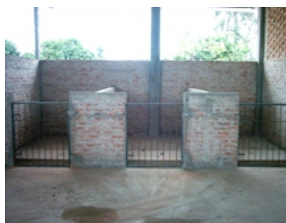
Tres padrilleras con piso mampostería y rejillas en la parte baja.
