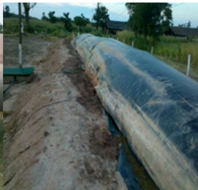
Gasógeno – Biogás - Las Breñas.
