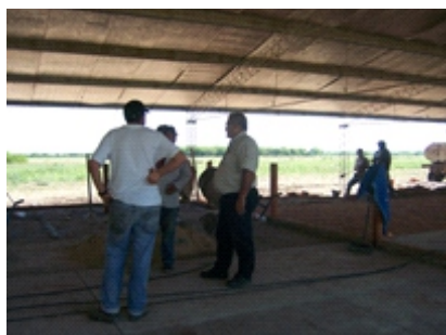
Pista de terminación en construcción.
