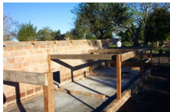
Boxes de mampostería de destete - recría, techo chapa, comedero tolva - Corrientes.
