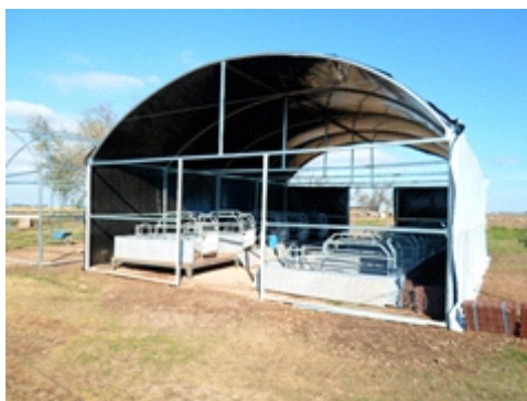
Maternidad con techo hierro estructural y cobertura de plástico, piso cemento - Marcos Juárez.
