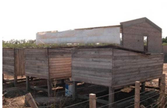
Cajón de destete a campo para una camada - Concepción del Bermejo - Chaco.
