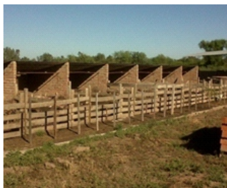
Batería de parideras mampostería - Sáenz Peña - Chaco.
