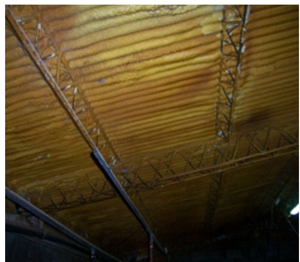
Techo de maternidad con poliuretano expandido - Sáenz Peña - Chaco.
