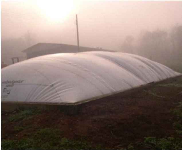
Tratamiento de efluente porcino – Biogás – Geomembrana vinimanta - Brasil.
