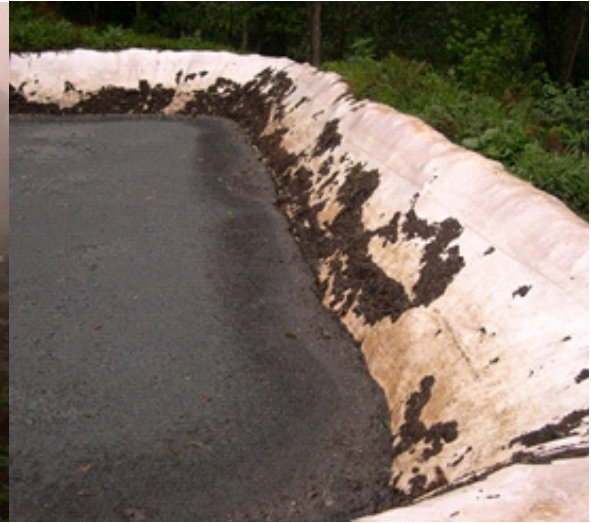
Estanque receptor impermeabilizado conteniendo sustrato orgánico - biofertilizante.
