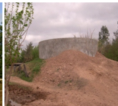
Tanque australiano de mampostería - Sáenz Peña.
