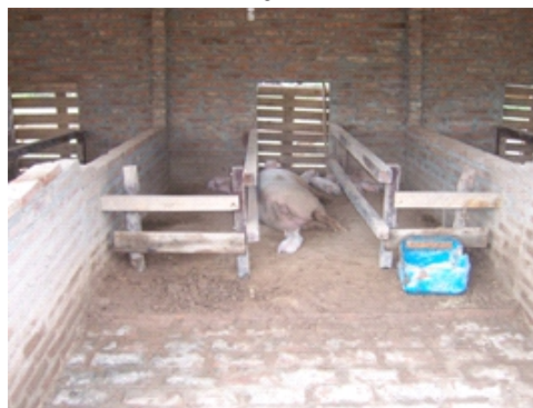
Paridera con jaula de madera - piso ladrillos - Miraflores - Chaco.
