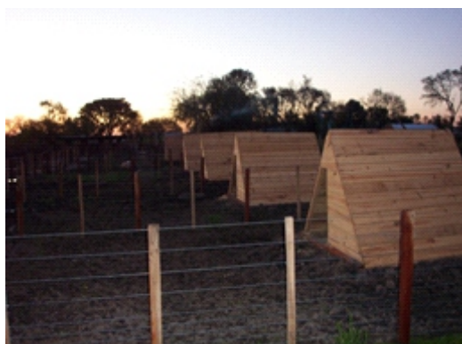
Paridera alpina sin techo levadizo con listones de madera de eucaliptus dispuestas a modo de tejas - Corrientes.
