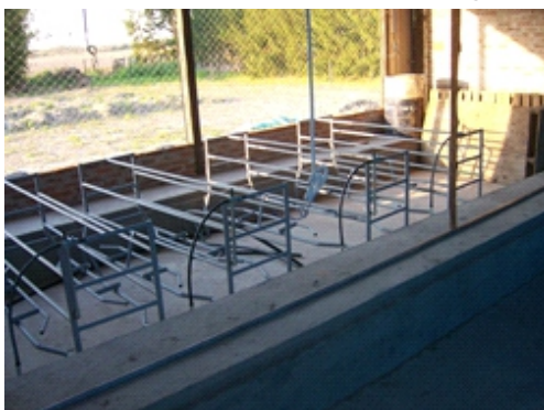
Jaulas de caño estructural construido por el productor - dispuesto en una fosa - falta colocar el eslat - Avellaneda - Santa Fe.
