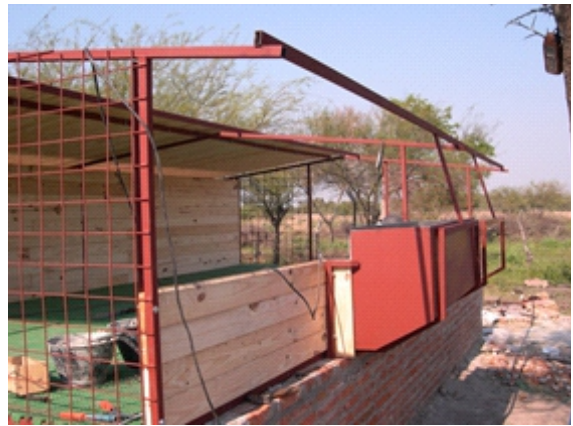
Módulo de Destete, hierro estructural, madera, chapa - Comedero con carga en el lateral - Corrientes.
