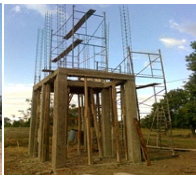
Estructura de base para el montaje de tanque de agua de 10000 litros - Las Breñas.
