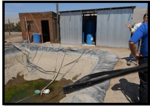
Figura 2 Pileta de drenaje de agua con B.
