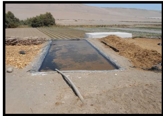
Figura 4. Pileta de almacenamiento de agua tratada.
